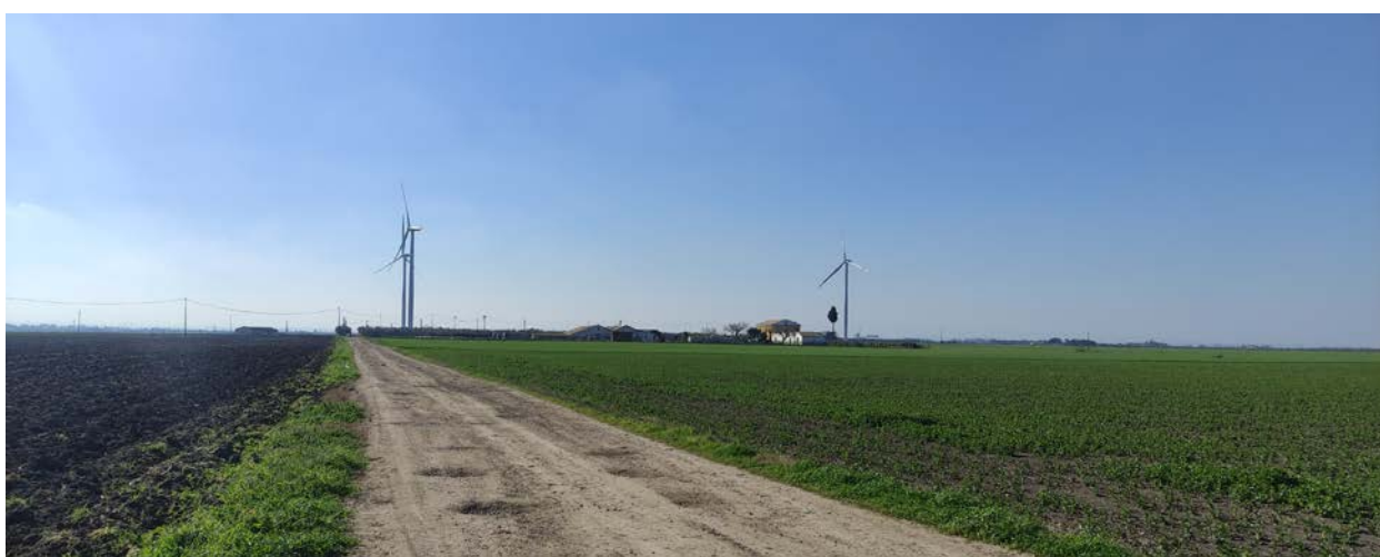
Vista dei terreni interessati dal progetto dell'impianto agrovoltaiico, in evidenza i tre aerogeneratori presenti
