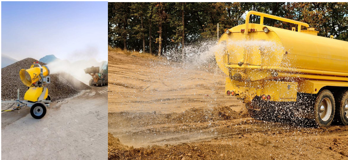
Figura 12 – Esempio di Irrorazione delle aree di cantiere
