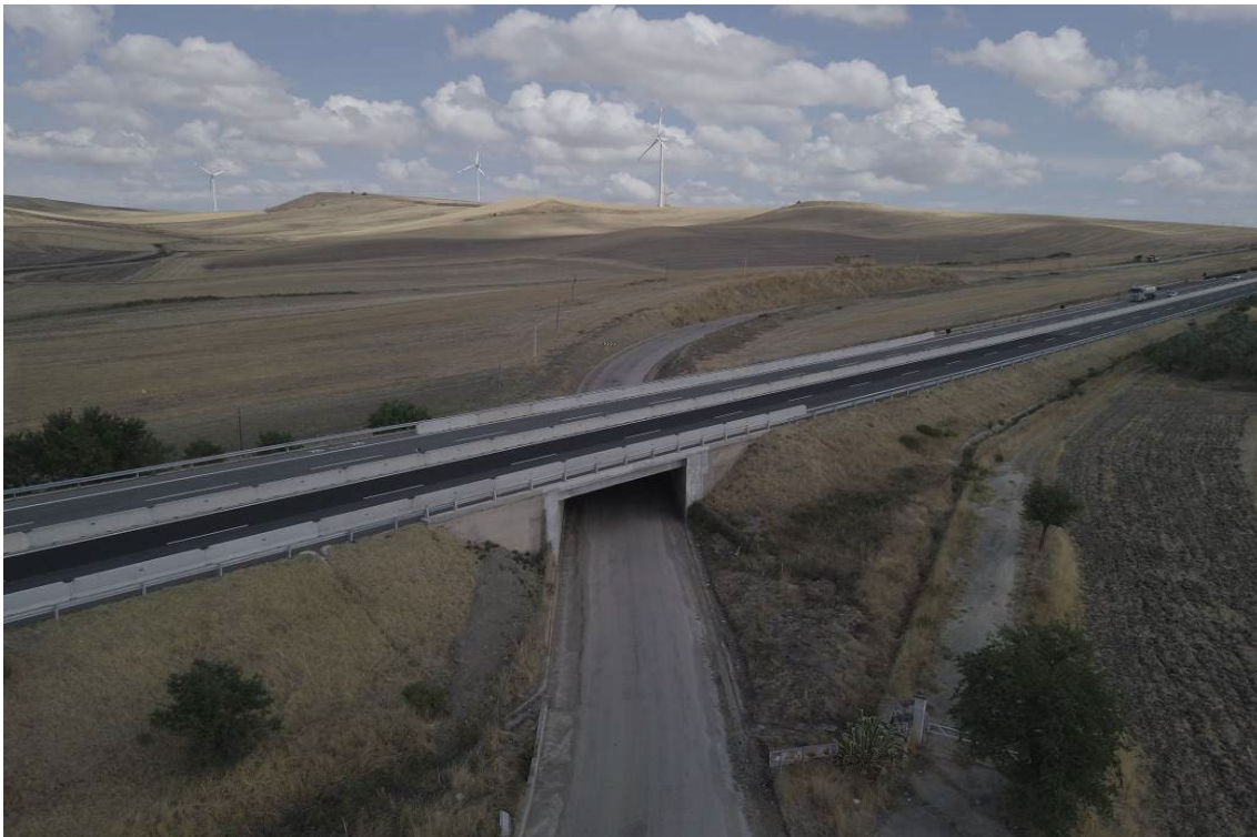
Figura 41: Foto 9 – SP90 passaggio cavidotto MT
