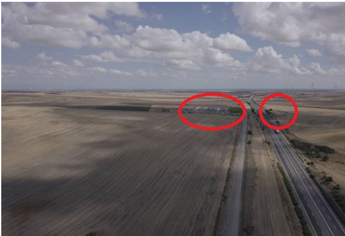
Figura 42: Foto 10 – Stazione RTN di Terna (a) e vista dell'area stazione elettrica di utenza (SEU) e stazione di raccolta (SER) (b)
