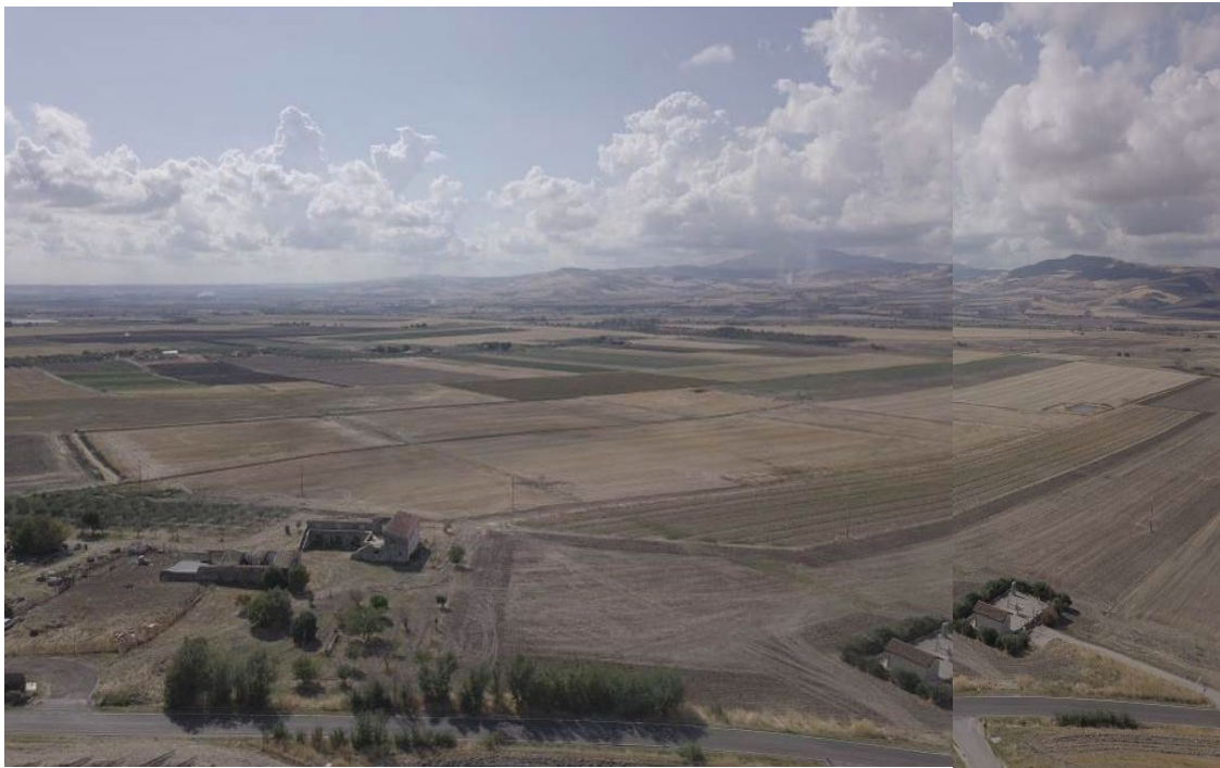
Figura 37: Foto 5 –Impianto Lotto 3
