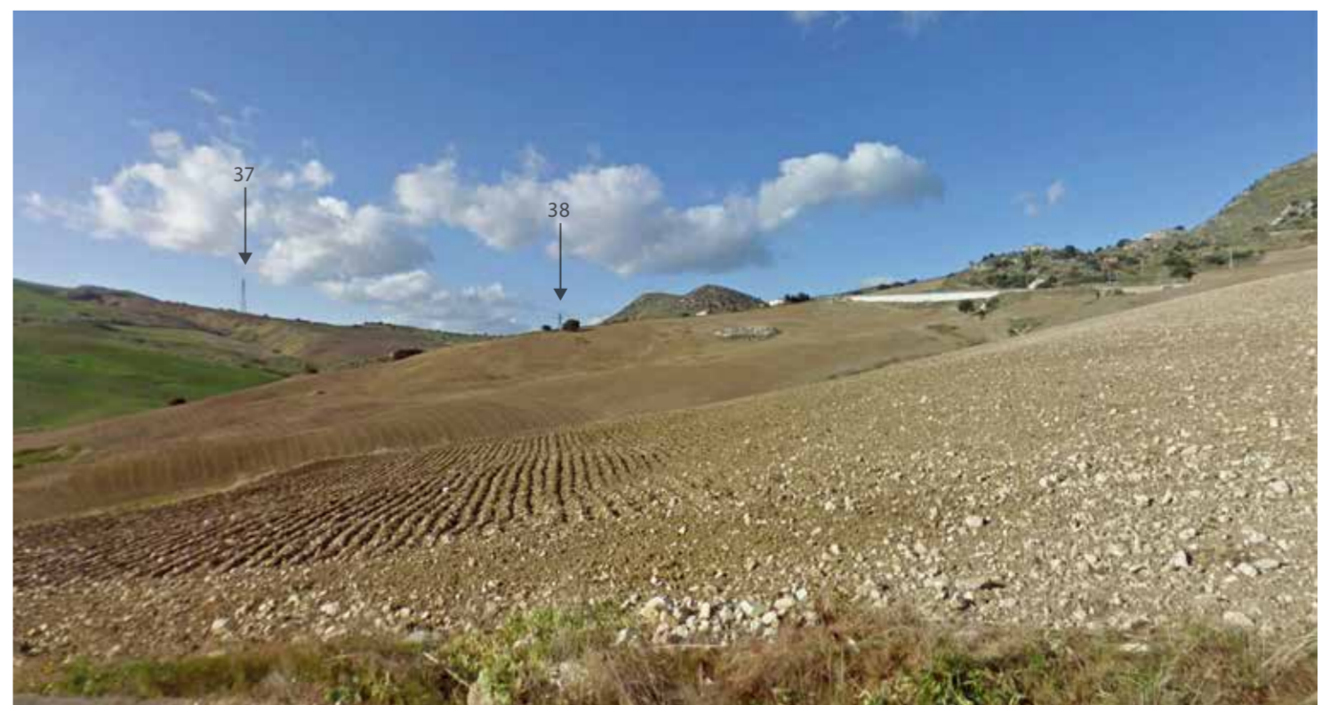
POST Interferenza con tratti panoramici Sostegni Elettrodotto Aereo AT n. 37, 38
