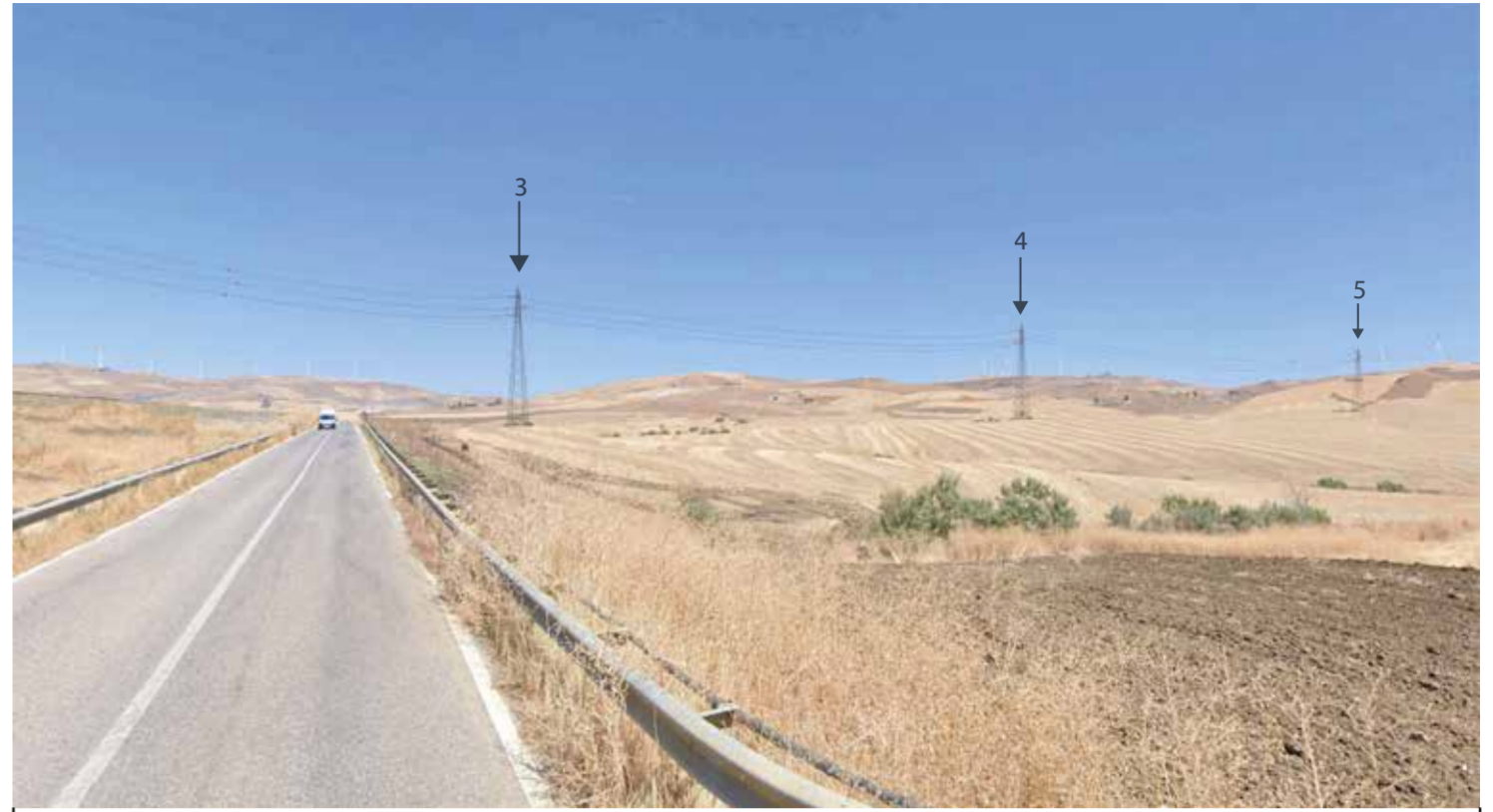
POST Interferenza con Sostegni Elettrodotto Aereo N n. 3, 4, 5
