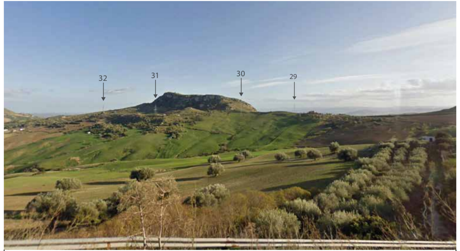
POST Interferenza con Sostegni Elettrodotto Aereo N n. 29, 30, 31, 32
