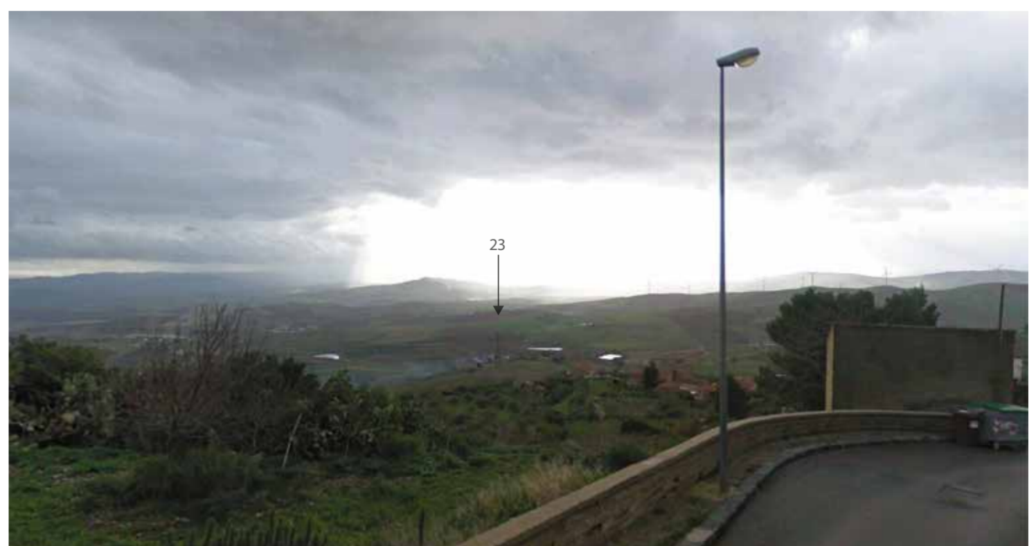
POST Interferenza con tratti panoramici Sostegni Elettrodotto Aereo AT n. 23
