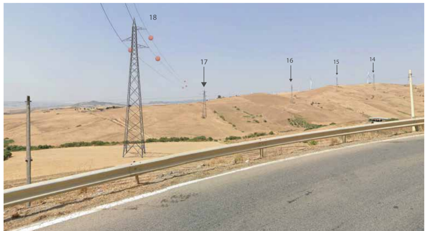
POST Interferenza con Sostegni Elettrodotto Aereo N n. 14, 15, 16, 17, 18,
