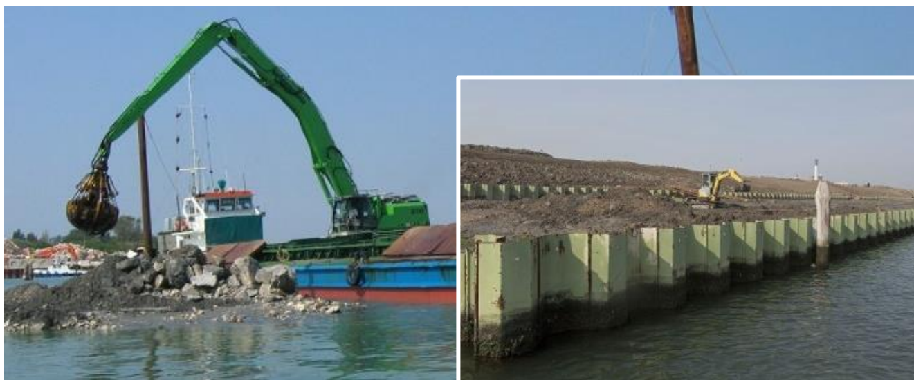
Figura 46 – Sbarco di materiale da motopontone autocaricante (a destra, Isola delle Tresse, Marghera)
