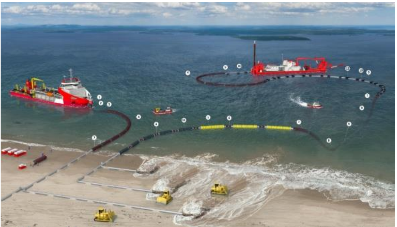
Figura 45 - Operazioni di refluitamento idraulico (Royal IHC, 2018)
