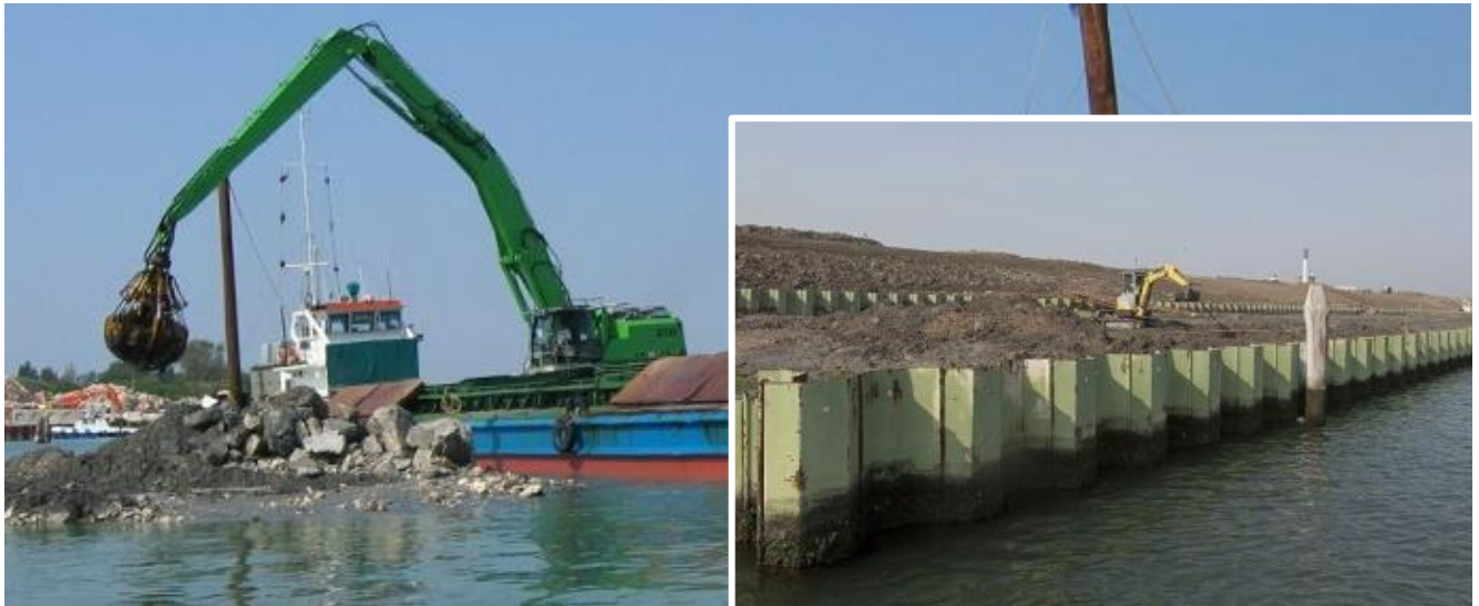
Figura 52 – Sbarco di materiale da motopontone autocaricante (a destra, Isola delle Tresse, Marghera)
