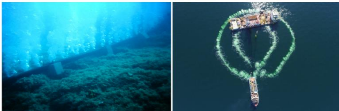
Figura 67 Zone con cortina di bolle rilasciata da un tubo perforato poggiato sul fondo (sinistra) e doppia cortina di bolle utilizzata intorno ad una imbarcazione (a destra) (@ hydrotechnik lübeck gmbh) https://www.offnoise-solutions.com/the-hydro-sound-damper-system-hsd-system/
