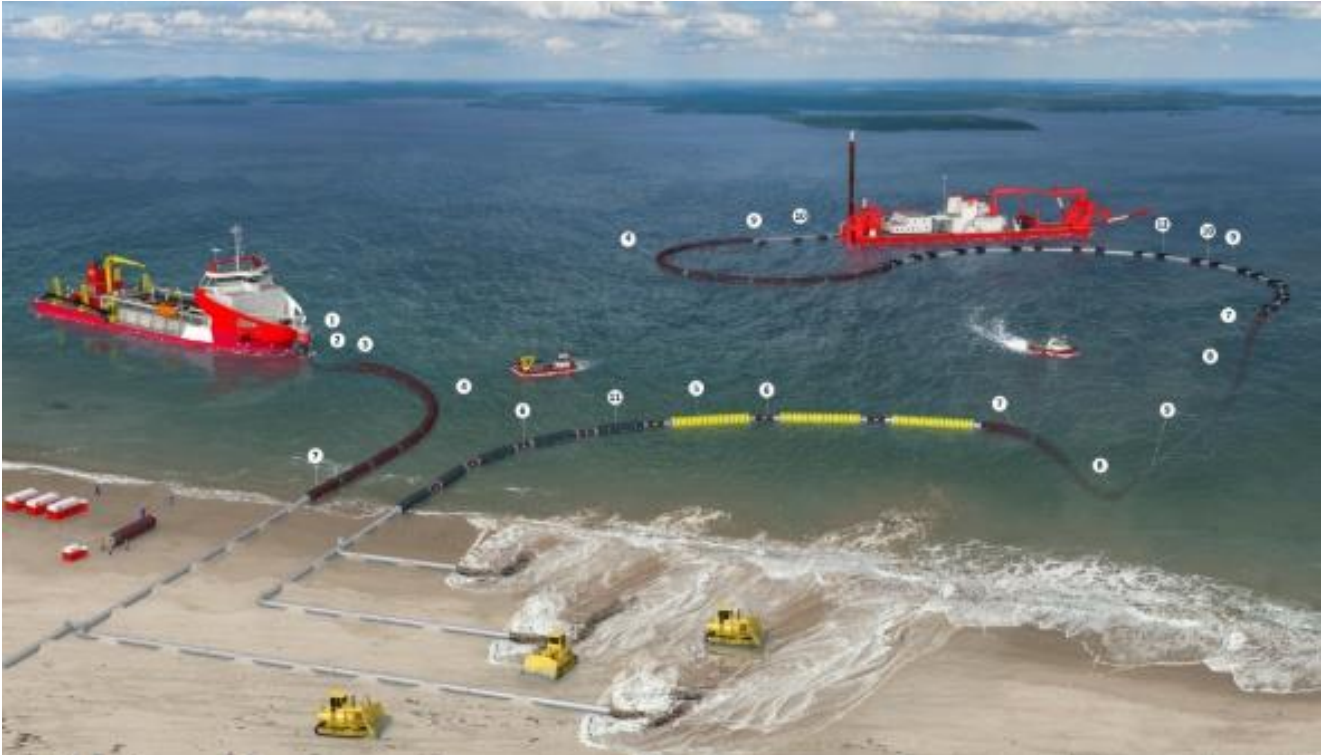
Figura 51 - Operazioni di refluito idraulico (Royal IHC, 2018)
