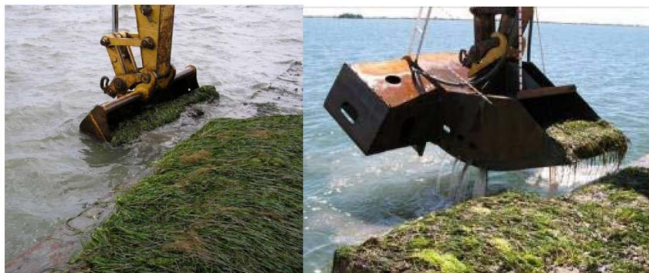
Figura 6: Fase di prelievo di grandi zolle mediante mezzi meccanici, con benna tradizionale (a sinistra) e con benna idraulica (a destra) recentemente messa a punto che permette di realizzare lo scavo per alloggiamento delle zolle contestualmente alla posa.
