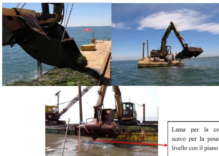
Figura 8: Benna idraulica appositamente realizzata per il prelievo di grandi zolle
