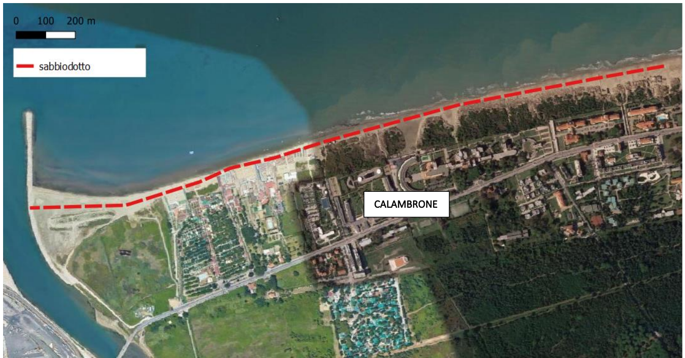
Figura 3.6: inquadramento territoriale della zona del Calambrone – ambito di interesse per il progetto del sabbiodotto
