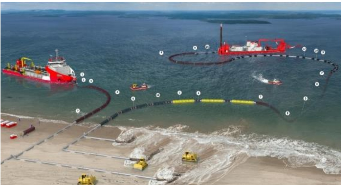
Figura 42 Operazioni di refluento idraulico (Royal IHC, 2018)
