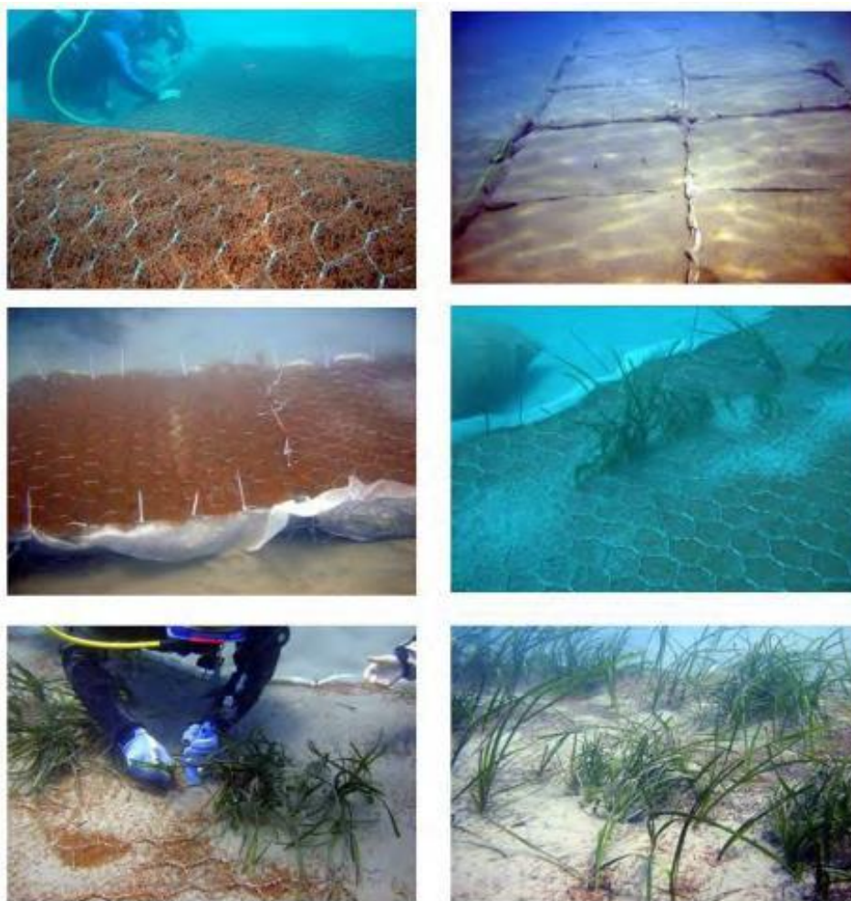
Figura 11: trapianto con materassi rivegetati - sequenza di fasi operativi (estratto da Linee Guida 106/2014 ISPRA – pagg. 67-68)
