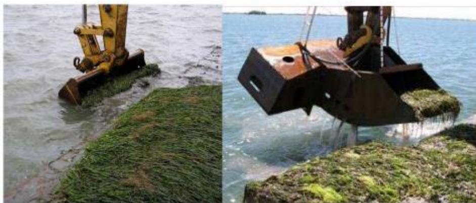
Figura 3.6 - Fase di prelievo di grandi zolle mediante mezzi meccanici, con benna tradizionale (a sinistra) e con una specifica benna idraulica (a destra) recentemente messa a punto, che permette di realizzare lo scavo per l'alloggiamento delle zolle contestualmente alla posa.
