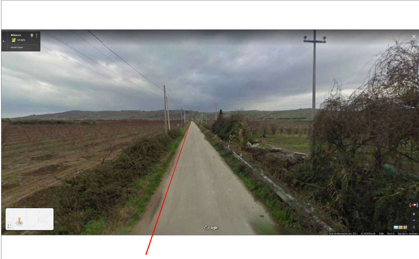
FOTO 6 – LINEA MT INTERRATA SU STRADA PUBBLICA
