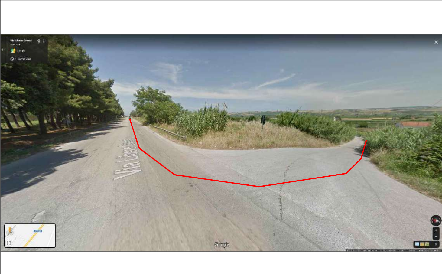
FOTO 10 – LINEA MT INTERRATA SU STRADA PUBBLICA
