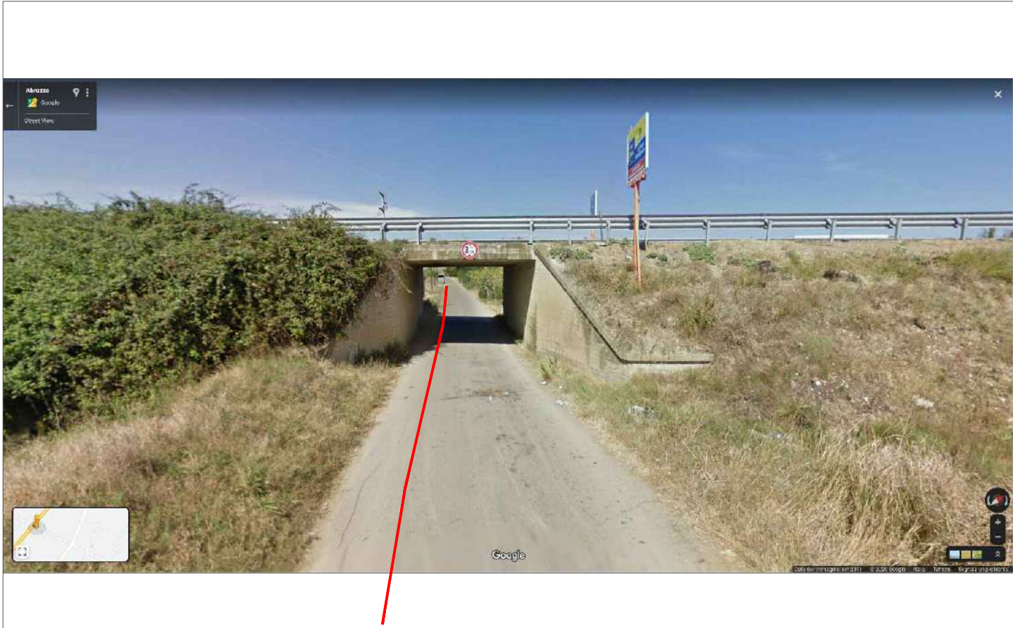
FOTO 9 – LINEA MT INTERRATA SU STRADA PUBBLICA
