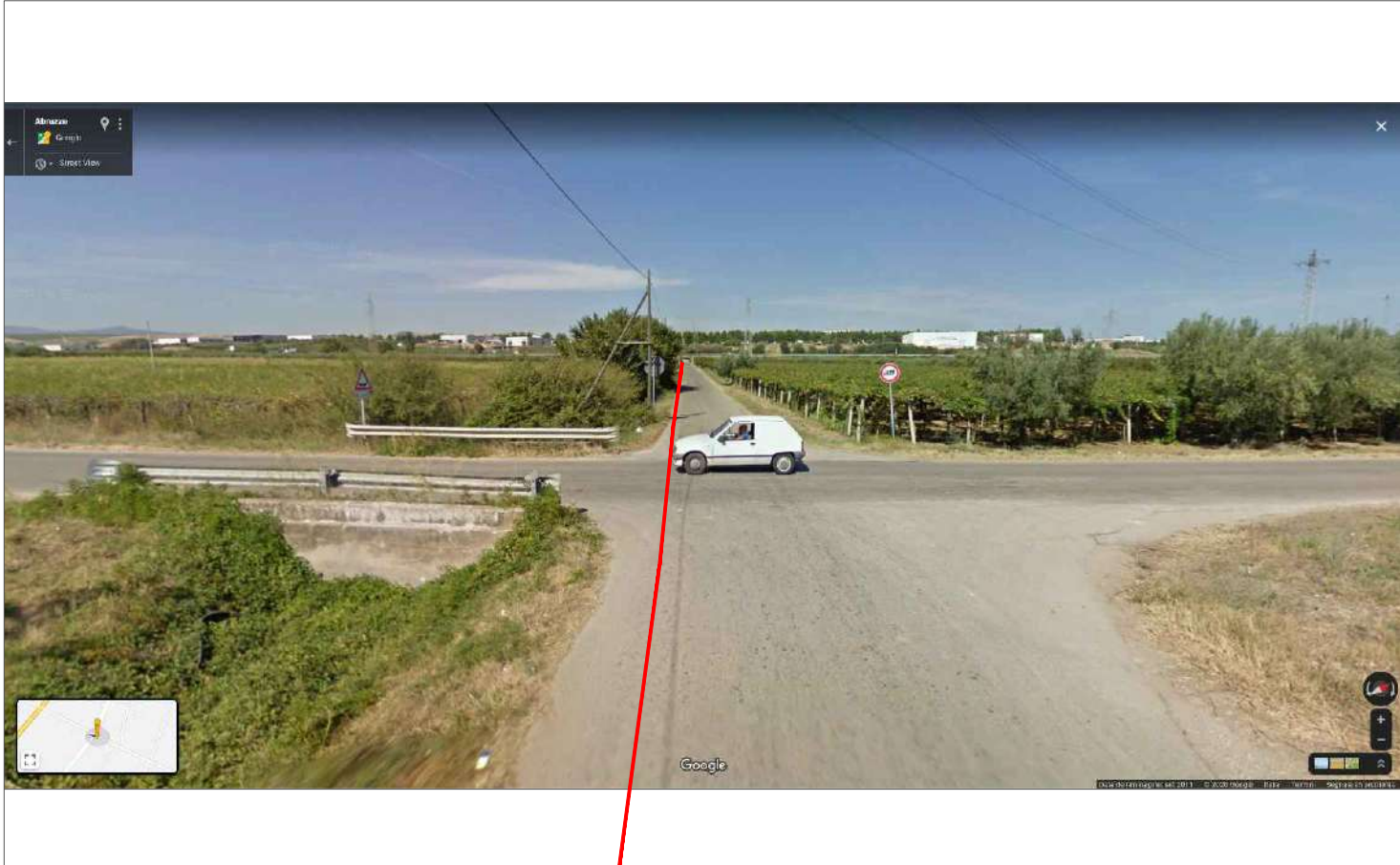
FOTO 8 – LINEA MT INTERRATA SU STRADA PUBBLICA
