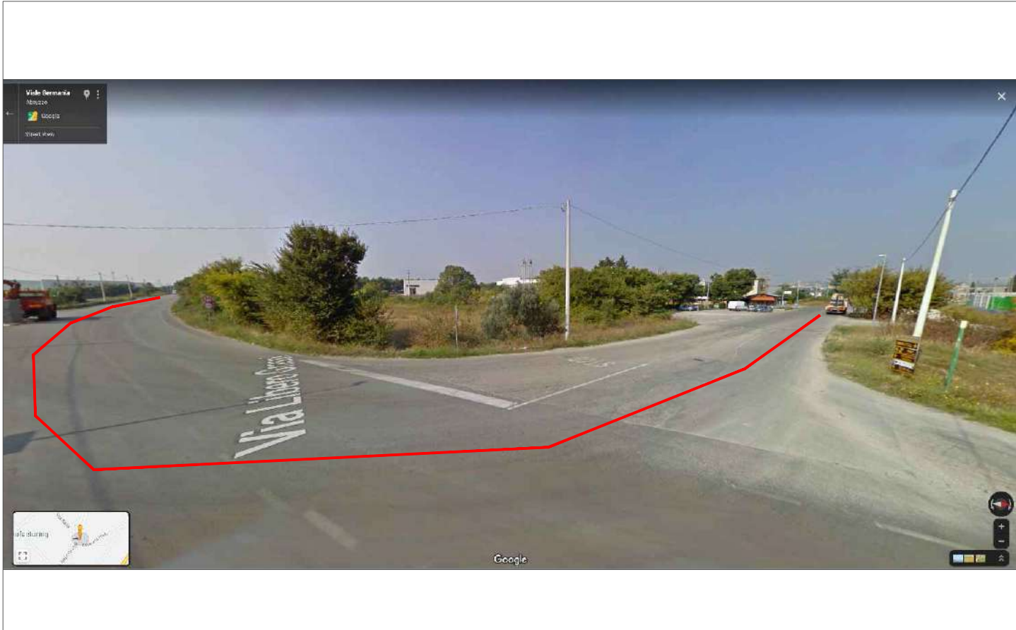
FOTO 11 - LINEA MT INTERRATA SU STRADA PUBBLICA
