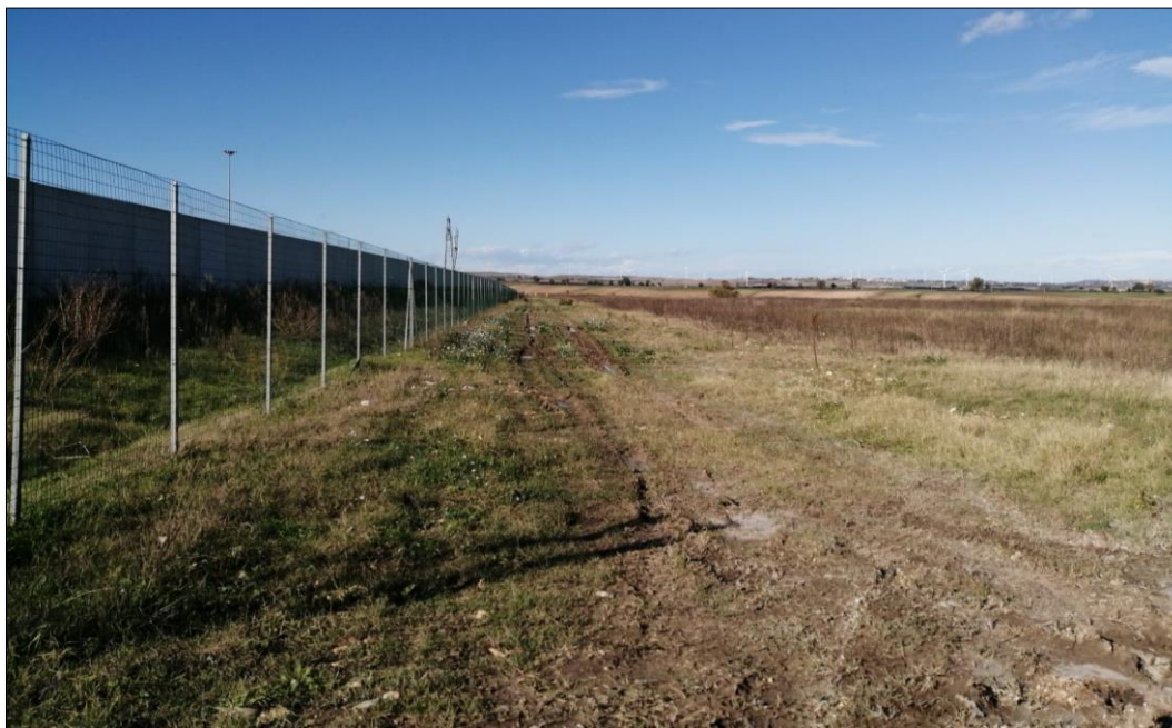
Figura 2-5: scatto verso NO, lungo i terreni che accoglieranno il tracciato del cavo AT di collegamento tra il Punto di Raccolta e la SE Rotello esistente.
