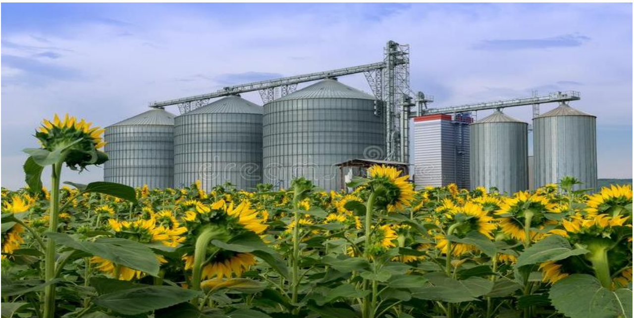
Figura 3-14: Impianto di conservazione dei cereali
