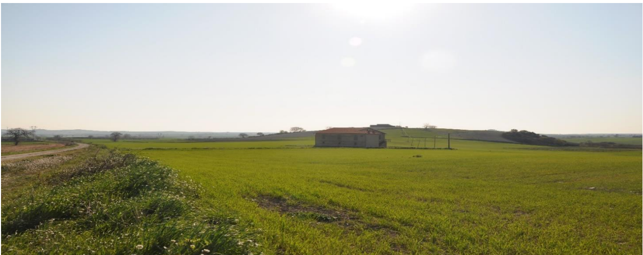
Figura 2-8: Impianto fotovoltaico Comune di Rotello, Area 4
