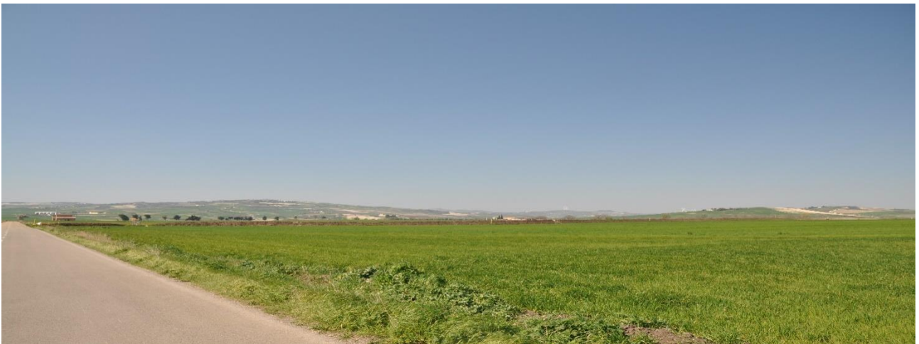
Figura 2-14: Impianto fotovoltaico Comune di Rotello, Area 10
