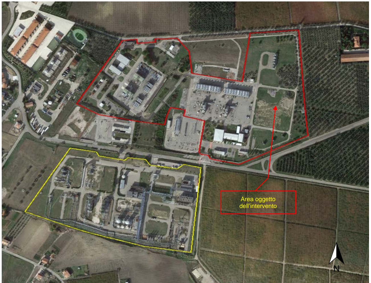
Figura 3-2: Impianto STOGIT di Fiume Treste. Il bordo rosso indica la centrale; il bordo giallo l'impianto trattamento.
