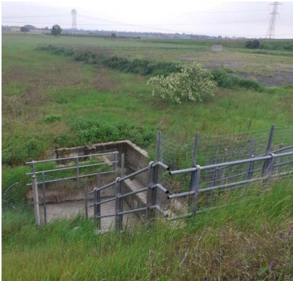
Figura 46 – Manufatto idraulico scatolare da adeguare posto alla p.k. 38+619 (vista dal rilevato esistente)
