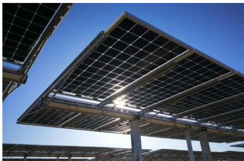
Figura 2-2: Esempio di struttura a tracker monoassiale
