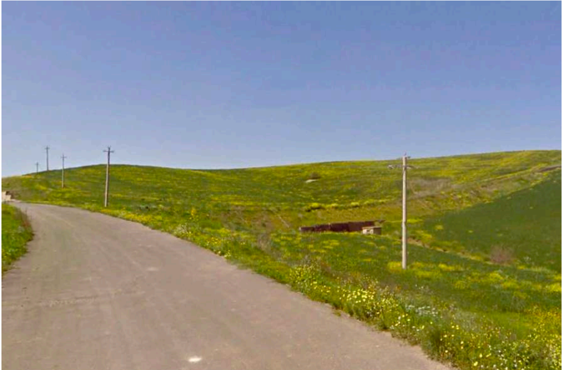
Figura 5.3 Fotografia del sito di intervento, stato antem operam – 2
