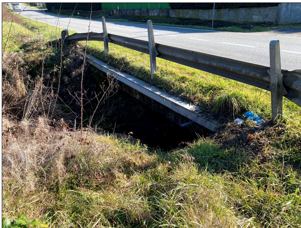
Figura 12. Punto di ripresa lato sinistro (percorrendo la strada dalla cabina di consegna alla cabina primaria).
