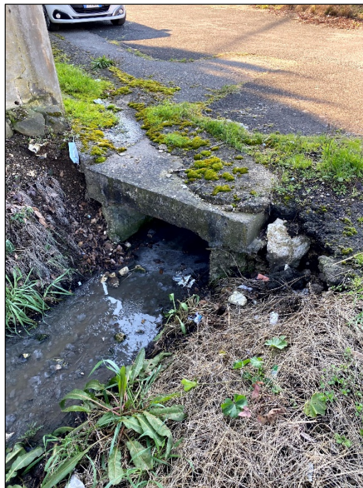
Figura 14. Punto di ripresa lato sinistro (percorrendo la strada dalla cabina di consegna alla cabina primaria).
