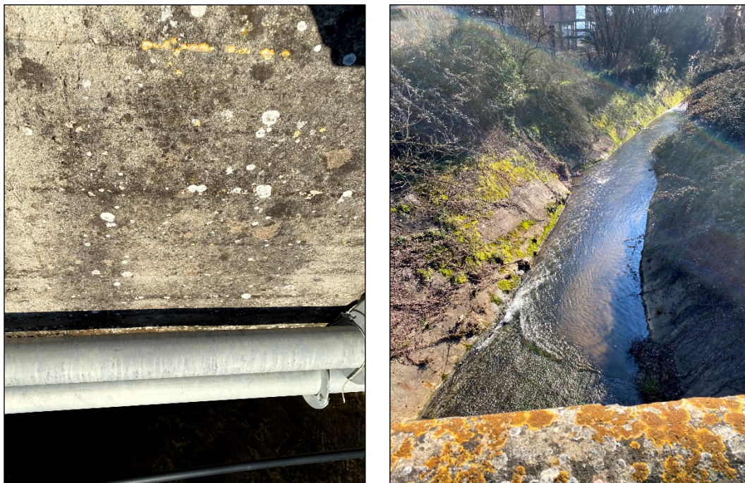
Figura 9. Punto di ripresa lato destro (percorrendo la strada dalla cabina di consegna alla cabina primaria).
