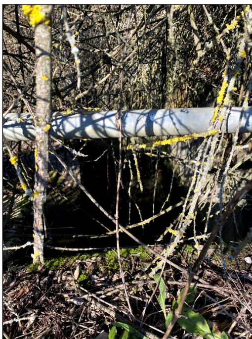
Figura 5. Punto di ripresa lato sinistro (percorrendo la strada dalla cabina di consegna alla cabina primaria).
