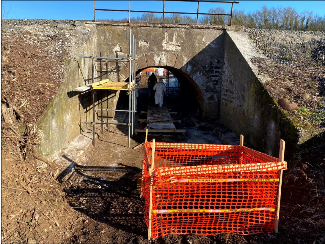
Figura 8. Punto di ripresa lato Sud (percorrendo la strada dalla cabina di consegna alla cabina primaria).
