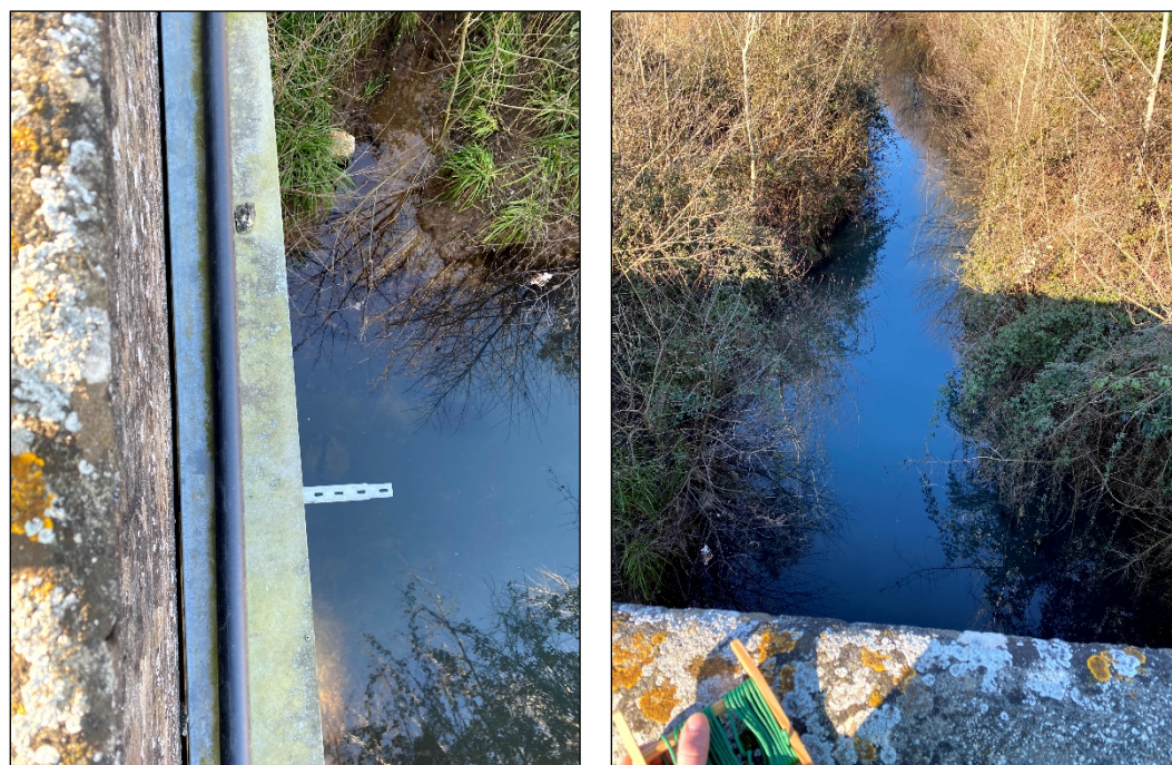
Figura 10. Punto di ripresa lato sinistro (percorrendo la strada dalla cabina di consegna alla cabina primaria).
