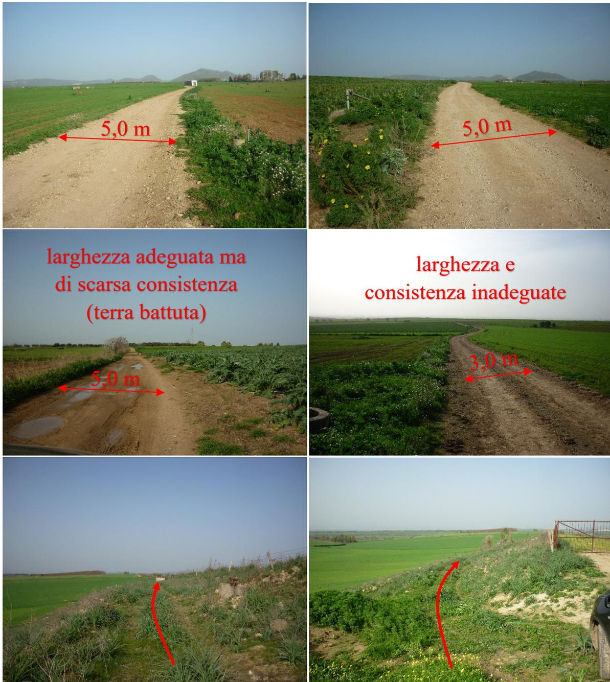
**Figura 36** Alcune foto rappresentative della viabilità interna al parco eolico. In alto: viabilità esistente che può essere utilizzata così com'è; al centro: viabilità esistente da adeguare per essere percorsa dai mezzi; in basso: viabilità di nuova realizzazione prevalentemente su battuti/tracce esistenti.
