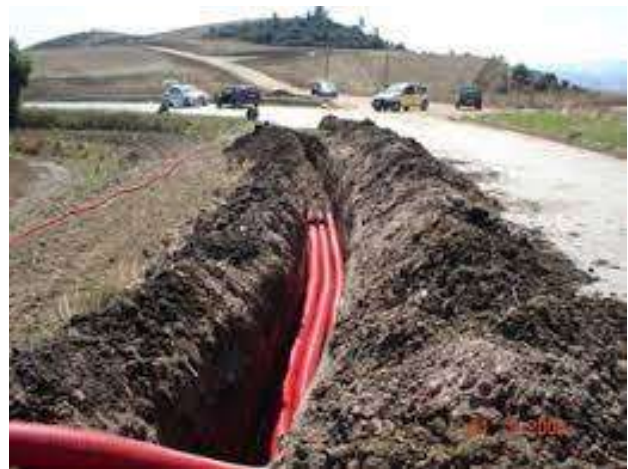
Figura 90 - Posa cavidotto MT tipo
