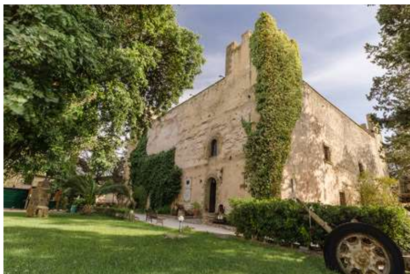
Figura 160 – Castello di Sanluri - Comune di Sanluri (VS) - Esterno
