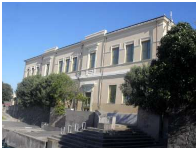
Figura 162 – Scuole Elementari - Comune di Samassi (VS) – Esterno
