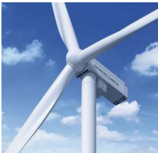
Figura 91 - Aerogeneratore Simens-Gamesa tipo – Navicella che ospita il trasformatore
