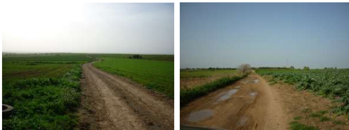
Figura 124 - Scatto fotografico della viabilità esistente interna al sito, ove si prevedono interventi di adeguamento
