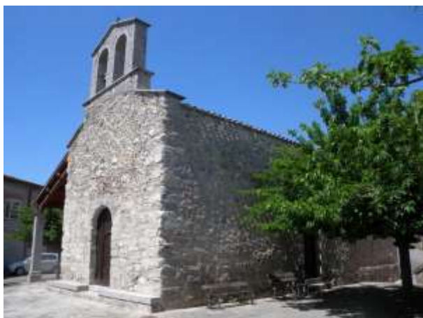
Figura 153 - Serrenti_Chiesa di San Giacomo
