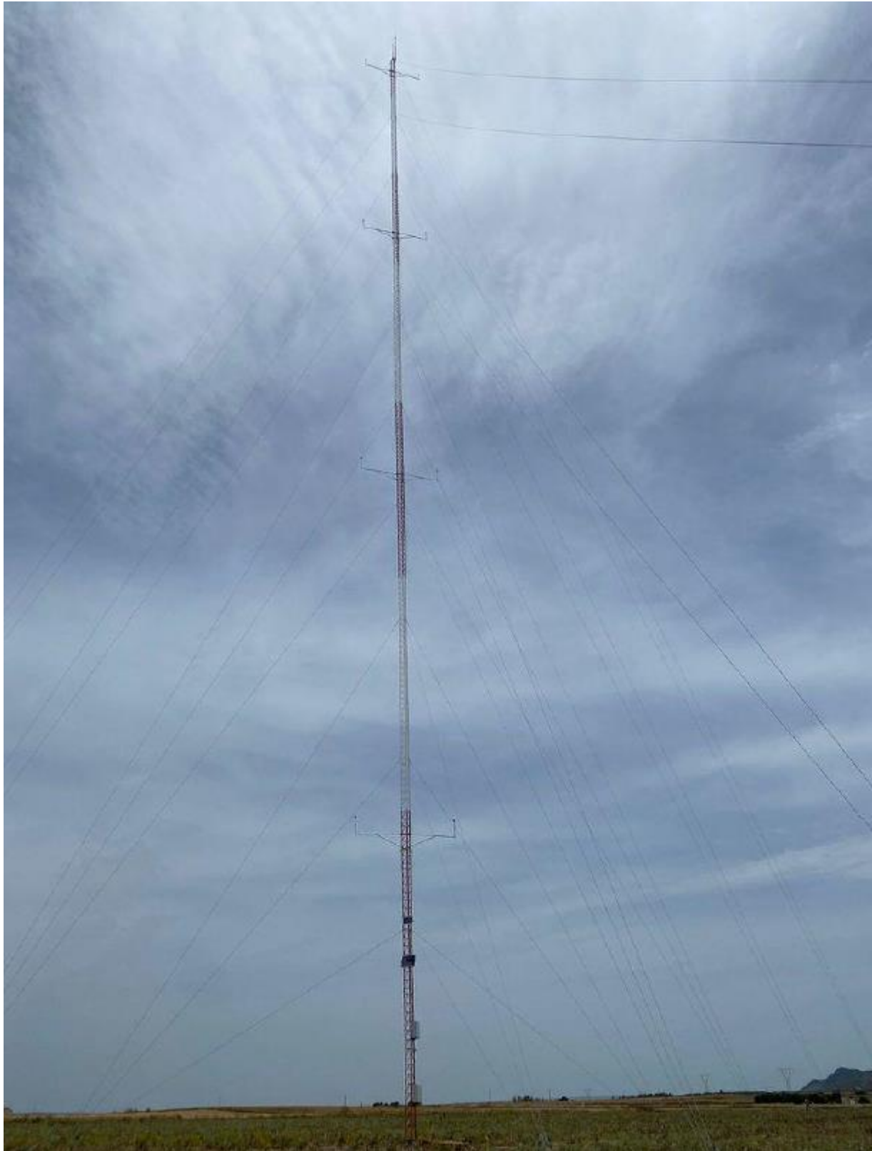
Foto: punto di installazione della stazione di misura da 93 metri a Samassi
