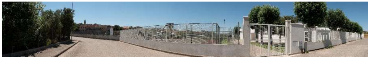
Stato di fatto del F39
