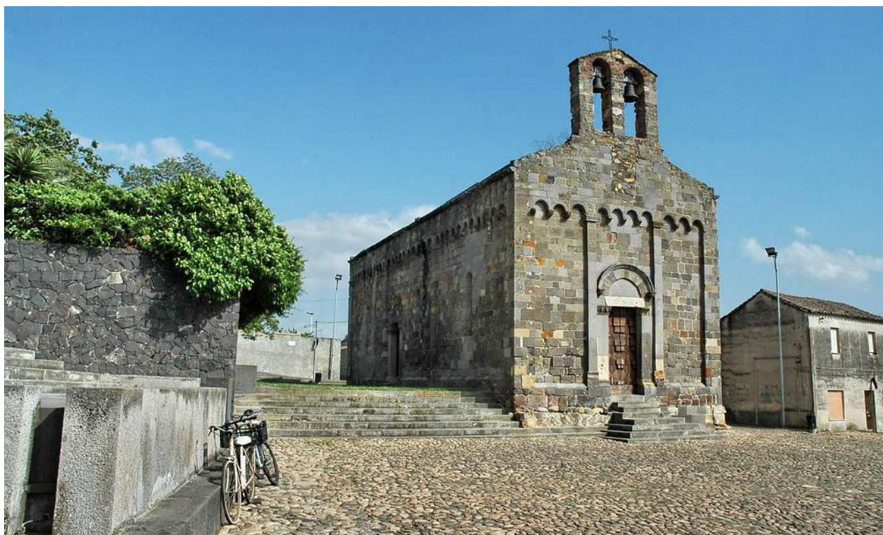
Figura 20 - Samassi_Chiesa San Gimiliano
