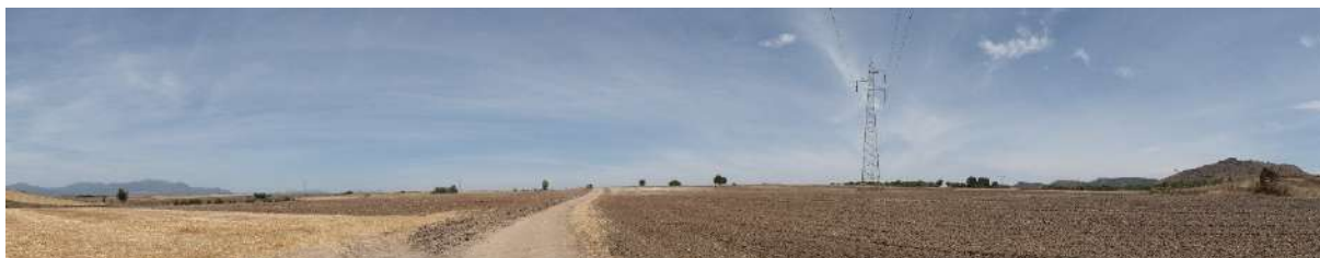
Stato di fatto del F90
