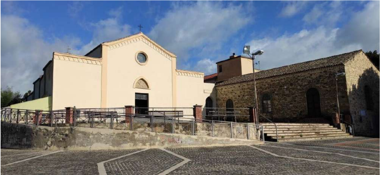
Figura 27 - Sanluri Chiesa di San Francesco d'Assisi
