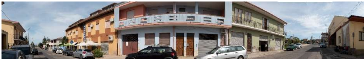
Stato di fatto del F27
