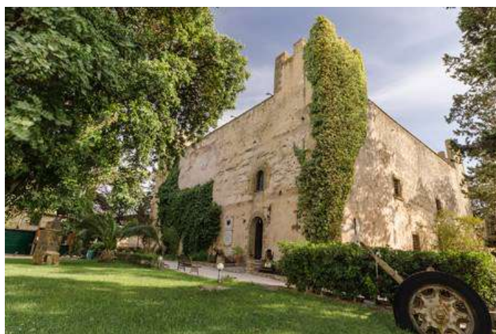
Figura 16 - Castello di Sanluri - Comune di Sanluri (VS) - Esterno
