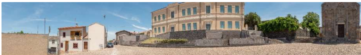
Stato di fatto del F21
