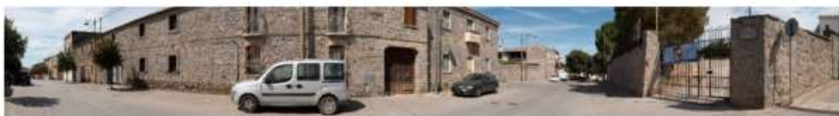
Stato di fatto del F18
