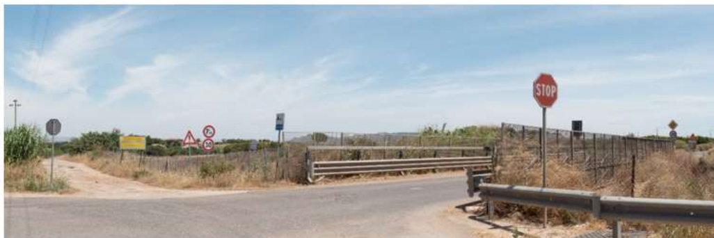
Stato di fatto del F20
