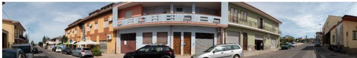
Stato di fatto del F27
