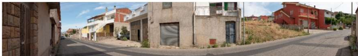
Stato di fatto del F35
