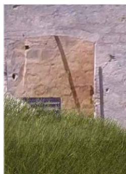
Dettaglio di facciata 3: stato di fatto
