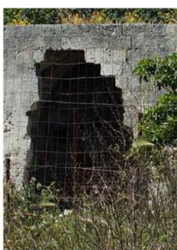
Dettaglio di facciata 1: stato di fatto
