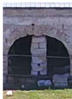
Dettaglio di facciata 4: stato di fatto
