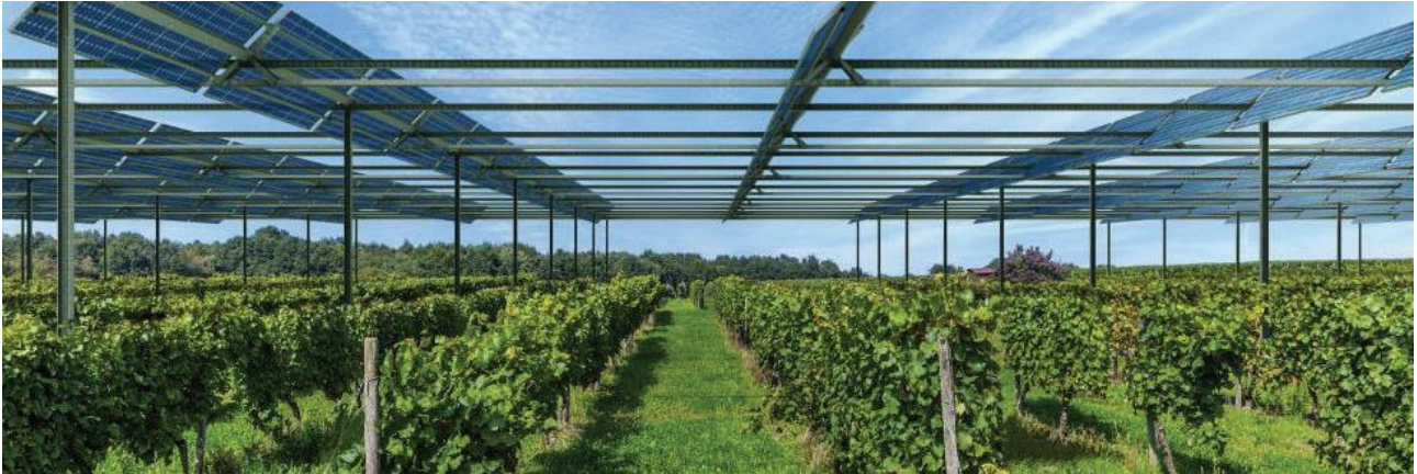
Figura 6. Sistema agrovoltaico realizzato su di un impianto di vite.
