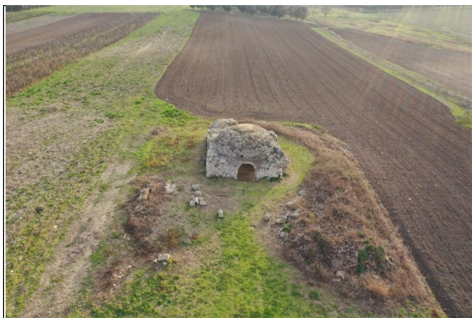
Figura 18 Chiesa S. Miserino (segnalazione n°4). Ripresa da drone da Nord
