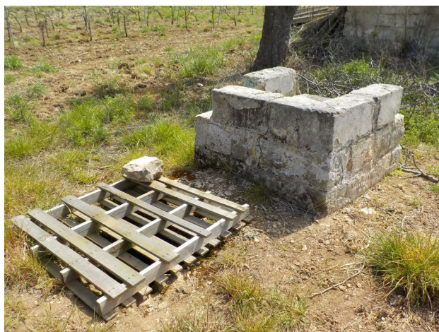
Foto 46. Vecchio pozzo rasente il piano campagna, con vicina una vasca.
