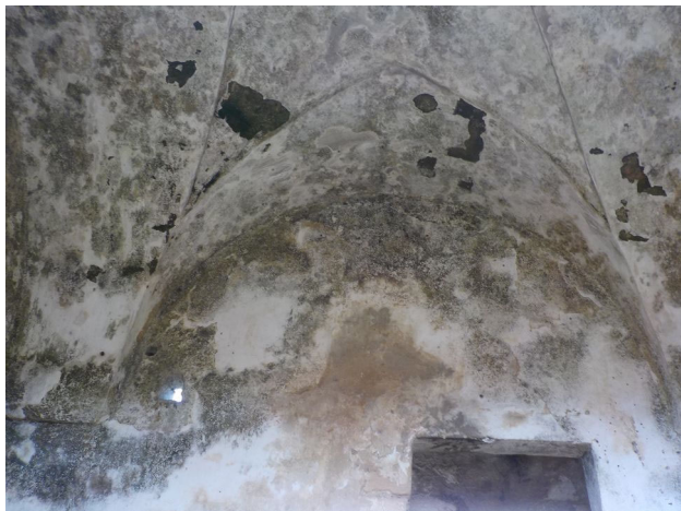
Foto 33. Interno della casetta con volta a squadro e camino.
