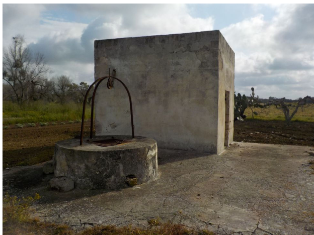
Foto 37. Casetta con vecchio pozzo.
