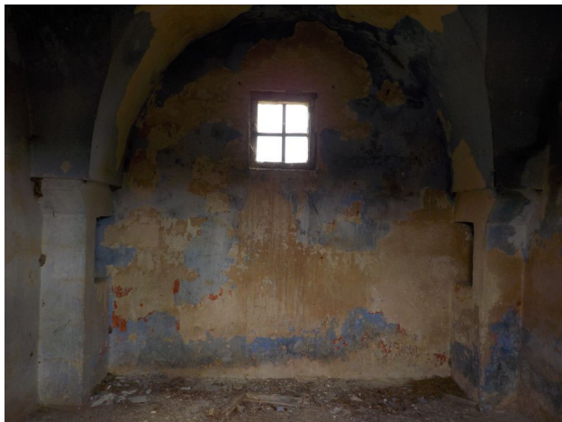
Foto 41. Il secondo vano con volta a squadro.
