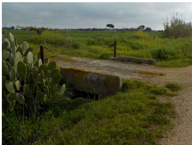
Foto 12. Opere di miglioramento fondiario risalenti alla Riforma Agraria: ponte e scolina.
