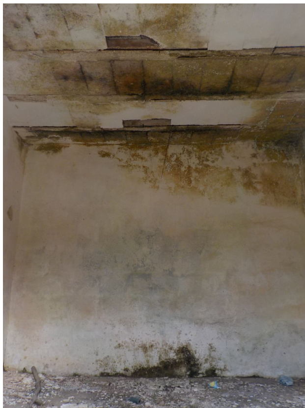
Foto 38. Interno della casetta precedente con solaio in latero-cemento.
