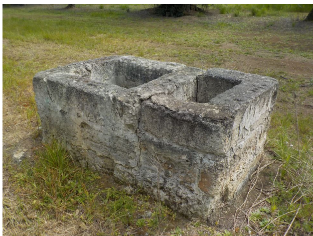
Foto 45. Bocca del pozzo con annessa vasca per la miscelazione dei primi fungicidi.
