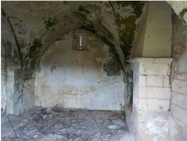
Foto 29. Interno dell'edificio precedente con volta a squadro e caminetto.
