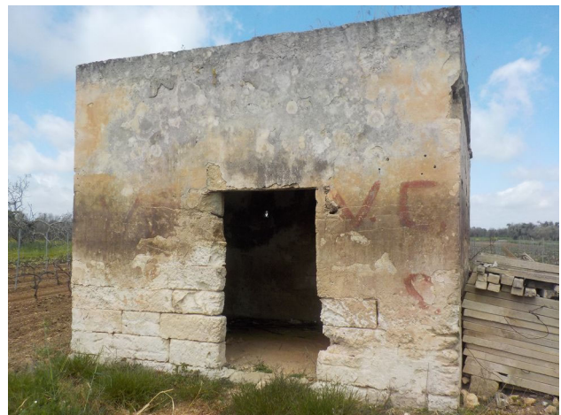
Foto 32. Tipico manufatto "A.1.j casetta".
