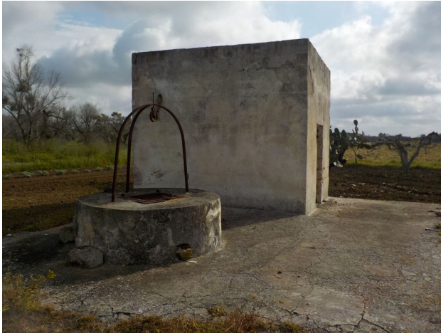
Foto 29. Casetta con vecchio pozzo.
