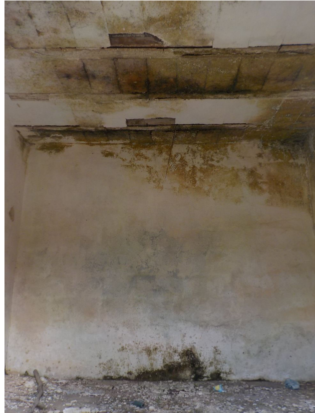
Foto 30. Interno della casetta precedente con solaio in latero-cemento.
