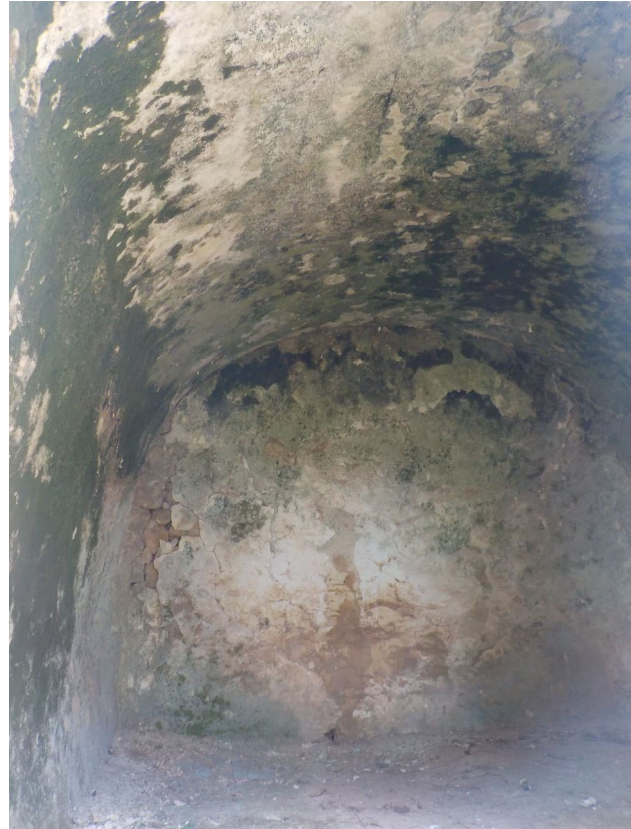
Foto 40. Interno della lamia intonacato e con volta a botte.
