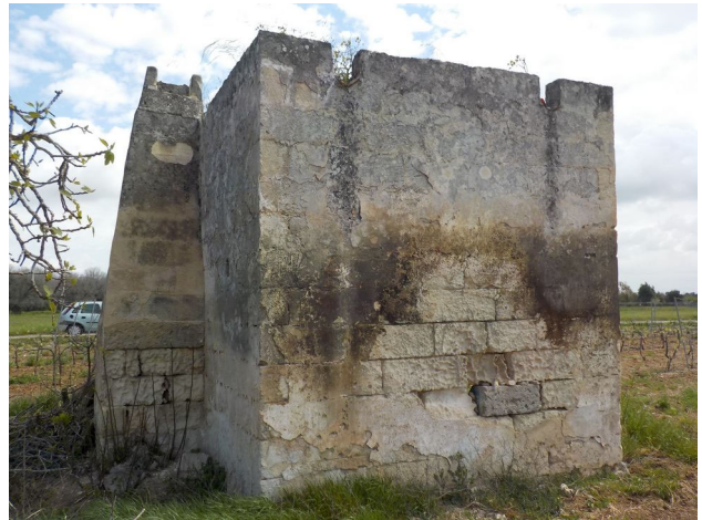
Foto 26. Vista posteriore dell'edificio precedente, in cui è visibile la sagoma esterna del camino.
