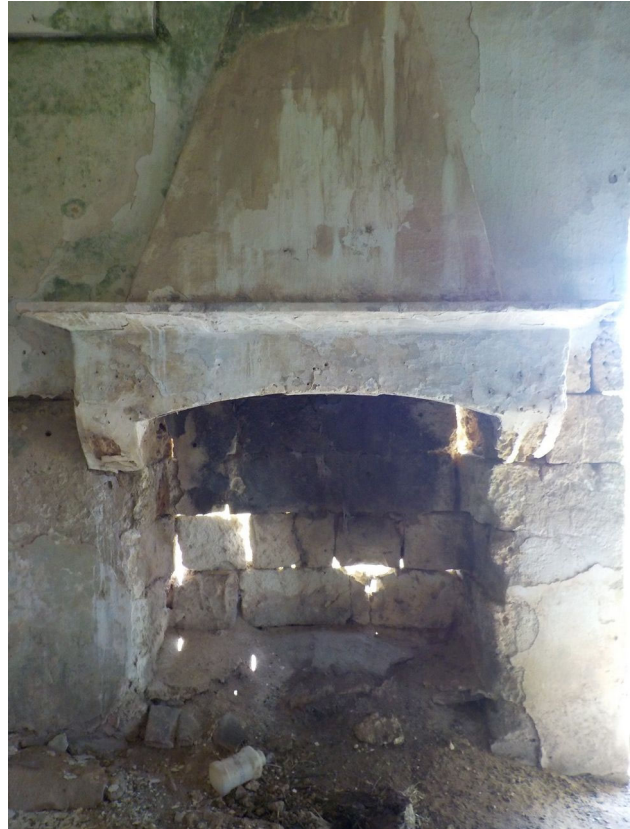
Foto 22. Particolare del caminetto.
