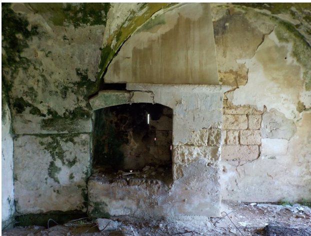
Foto 23. Particolare del caminetto nel secondo vano.
