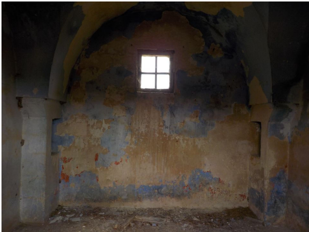
Foto 33. Il secondo vano con volta a squadro.
