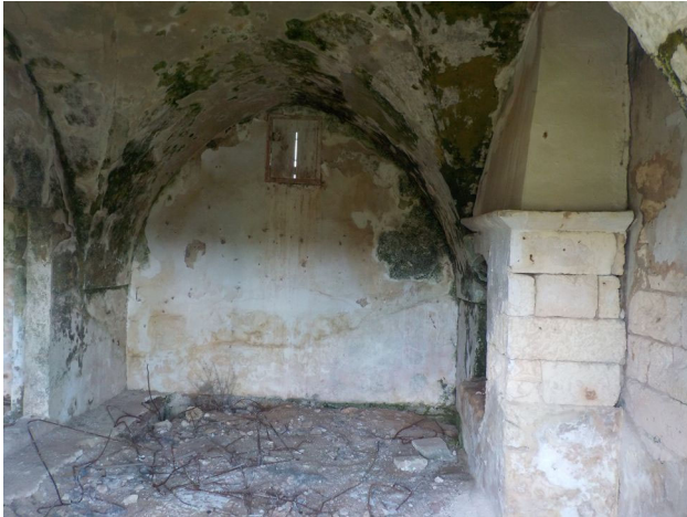
Foto 21. Interno dell'edificio precedente con volta a squadro e caminetto.
