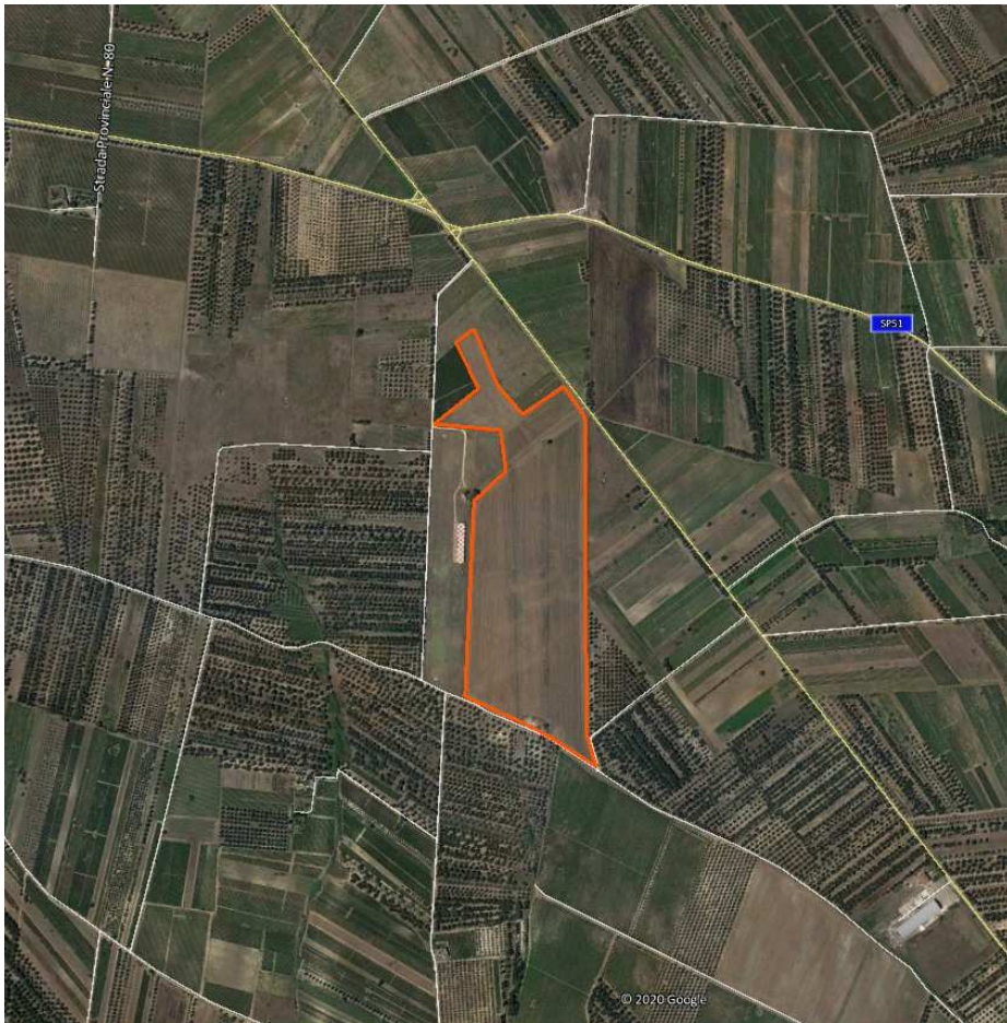
Immagine 1: Area interessata dall'impianto fotovoltaico Cellino San Marco
