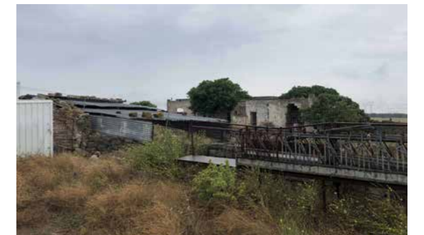
Foto masseria Roco Nuzzo, stato di fatto
