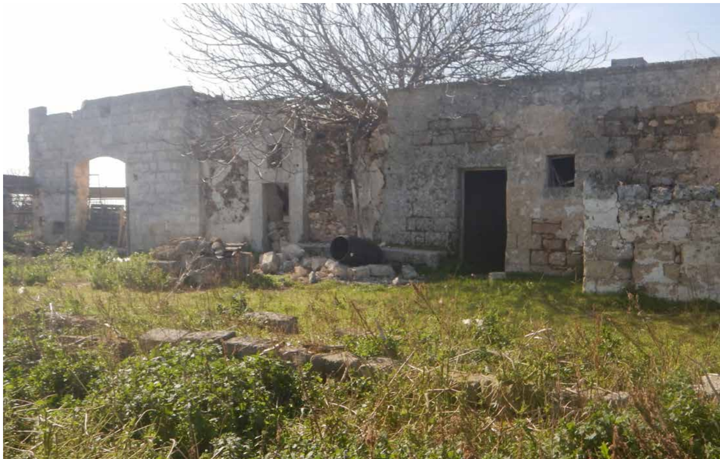
Foto Masseria Rocco Nuzzo stato di fatto
