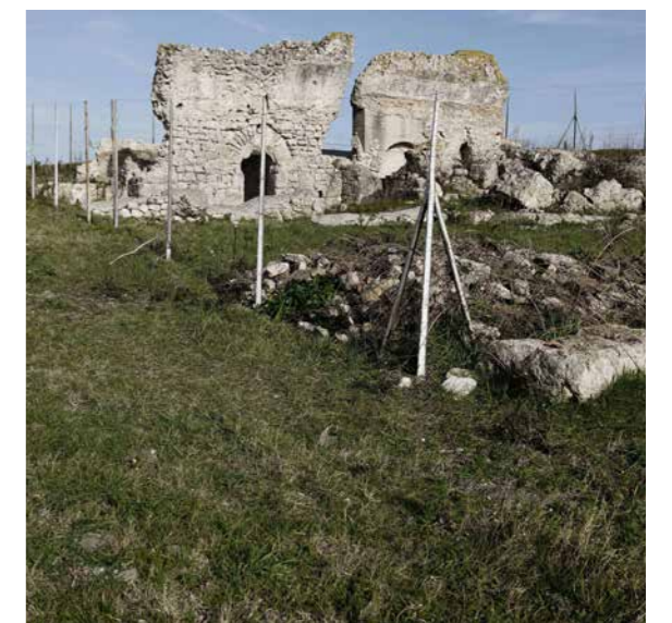
Foto area Terme di Malvindi, stato di fatto
