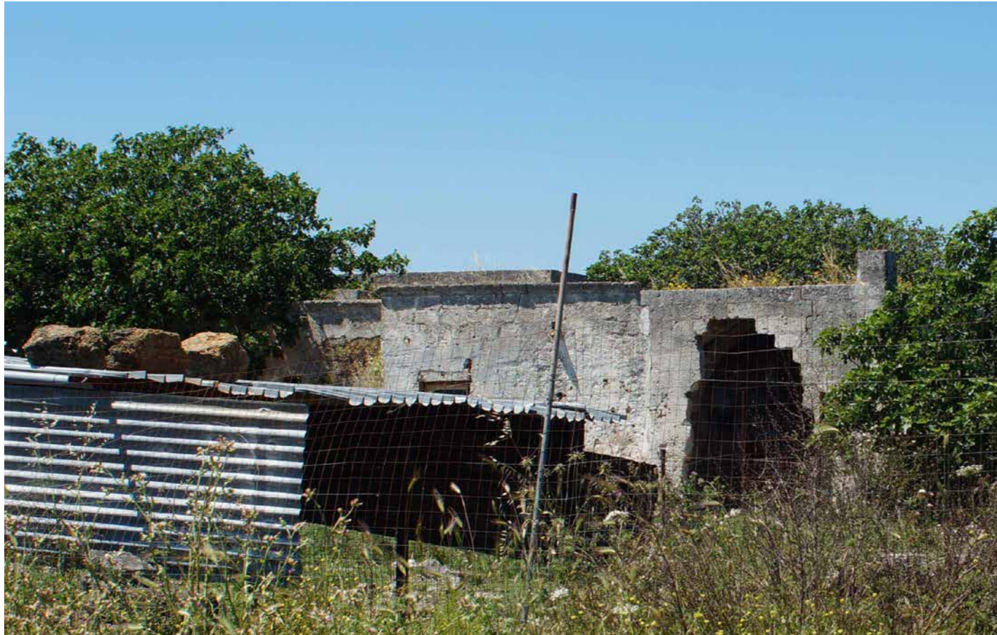
Foto Masseria Rocco Nuzzo stato di fatto
