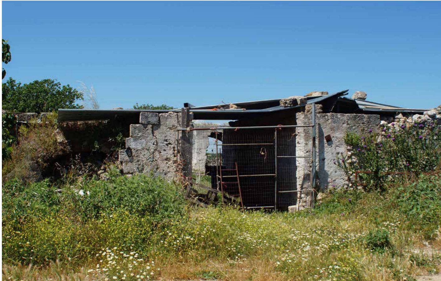
Foto Masseria Rocco Nuzzo stato di fatto
