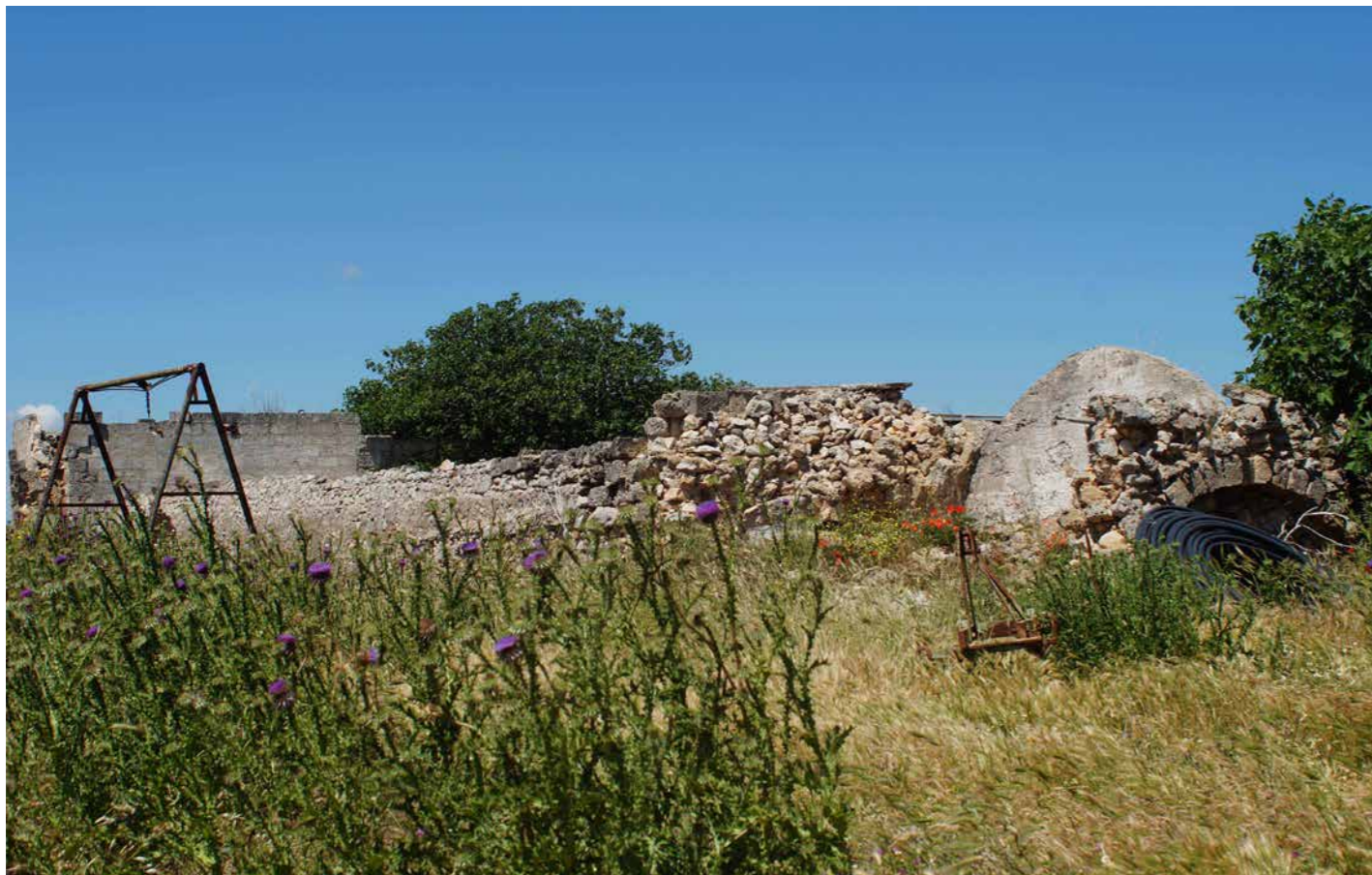
Foto Masseria Rocco Nuzzo stato di fatto
