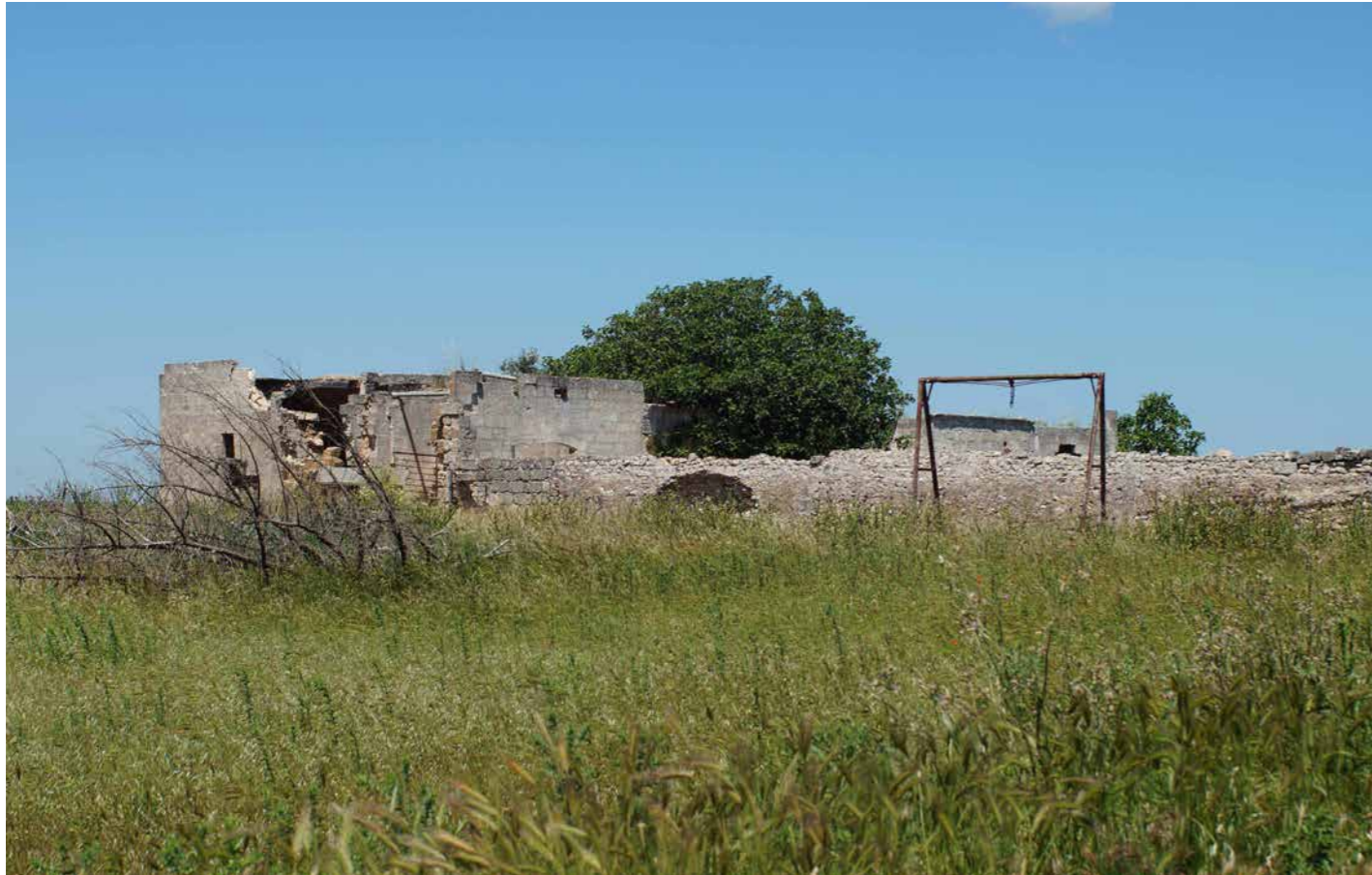
Foto Masseria Rocco Nuzzo stato di fatto
