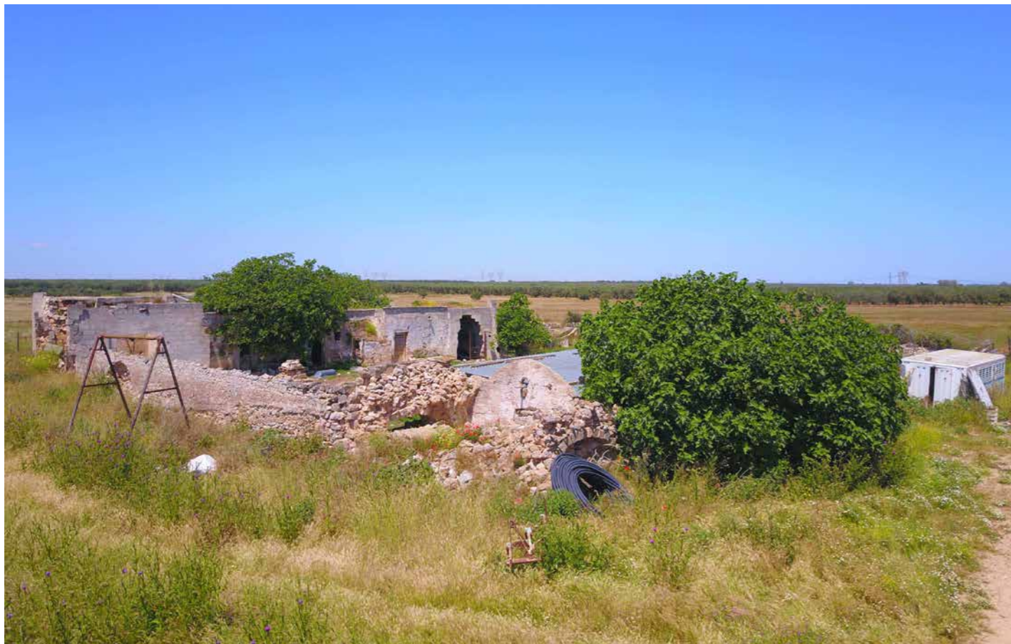
Foto Masseria Rocco Nuzzo stato di fatto
