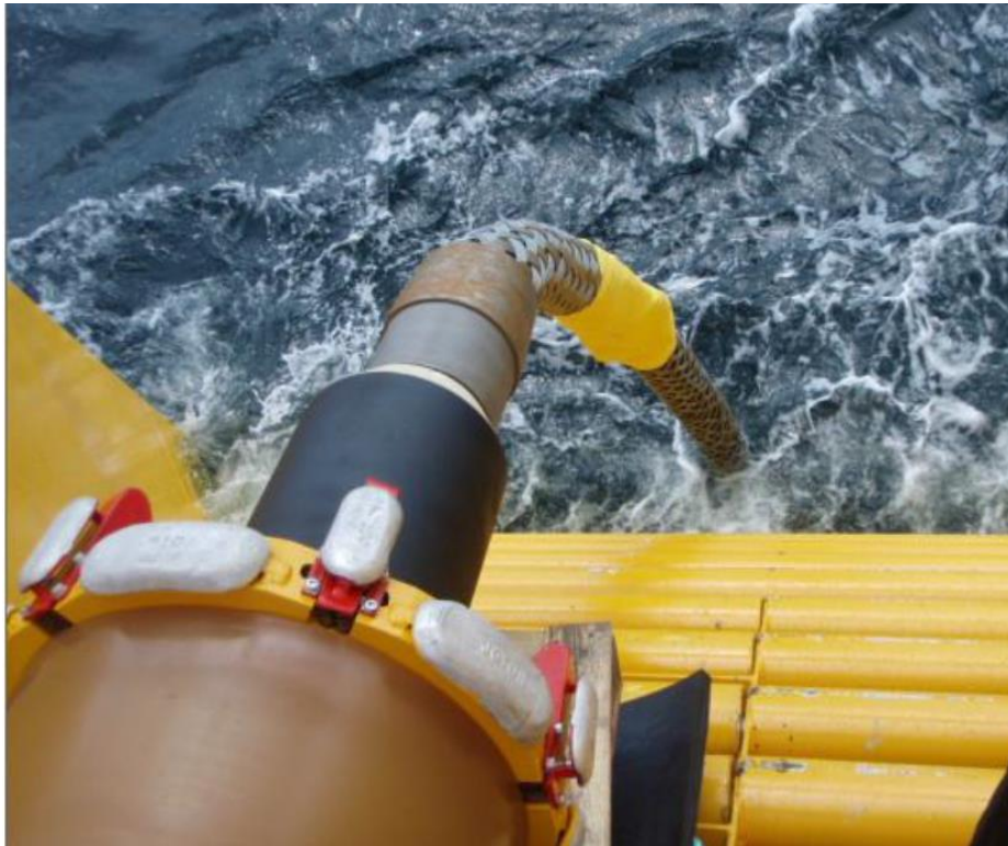
Figura 30 - Operazioni di installazione del cavo dinamico
