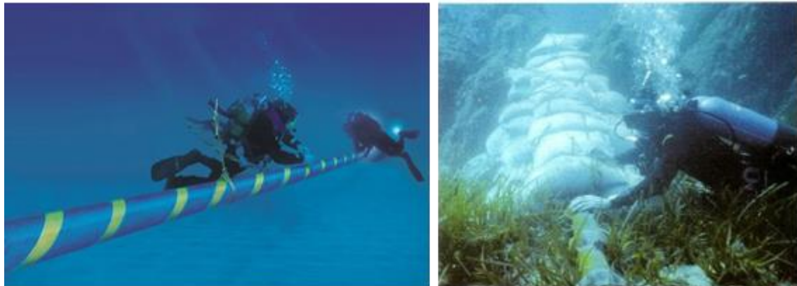
Figura 18 - Installazione e sistema di protezione di cavidotti marini adagiati sul fondale
