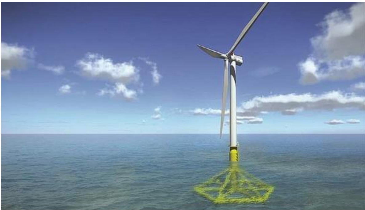
Figura 8 - Particolare della fondazione galleggiante di tipo floating
