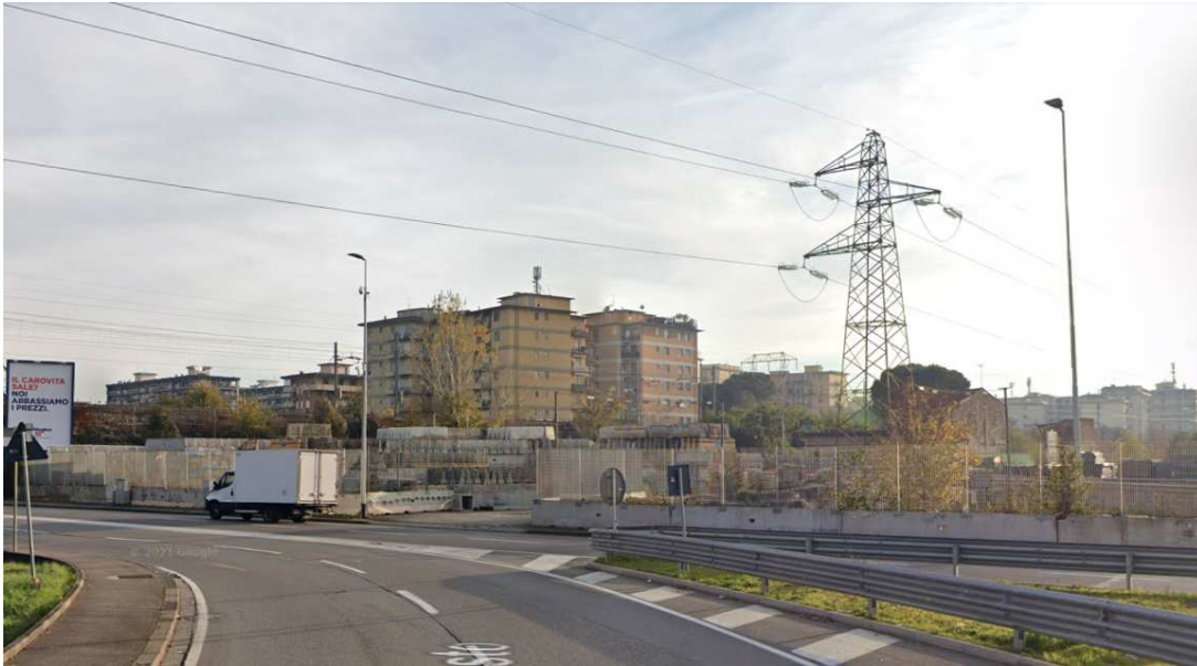
Figura 29 – Area destinata a deposito con traliccio
