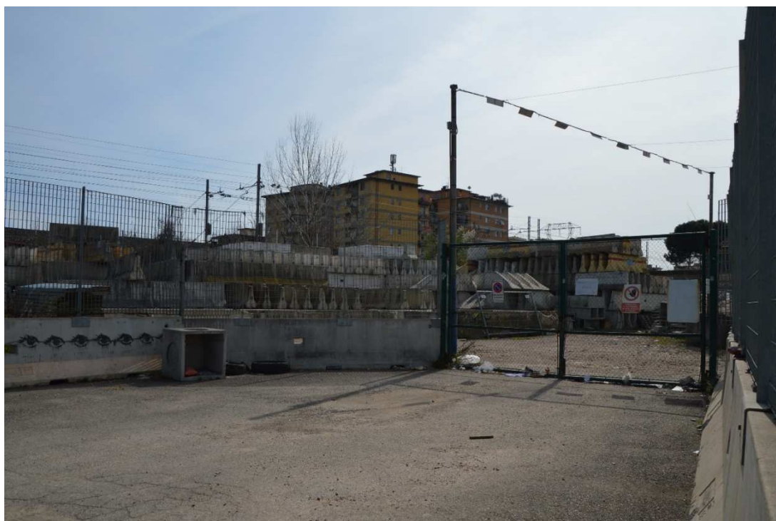
Figura 28 – Area destinata a deposito
