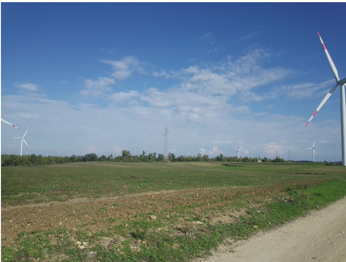
Figura 4 Vista dal punto 3
