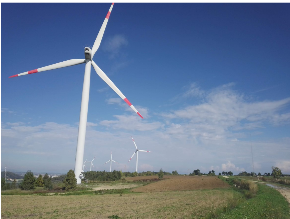
Figura 9 Vista dal punto 5
