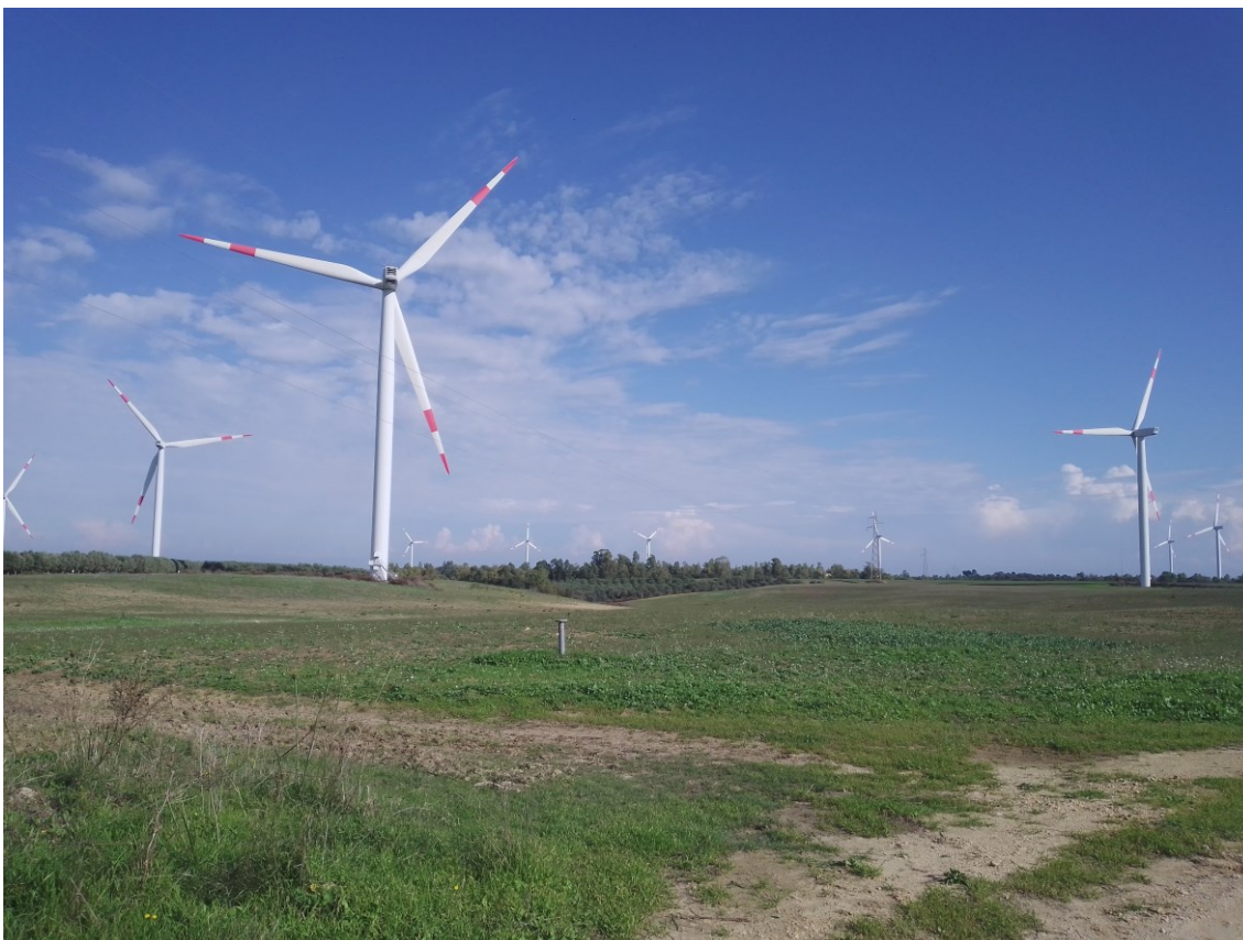
Figura 2 Vista dal punto 2
