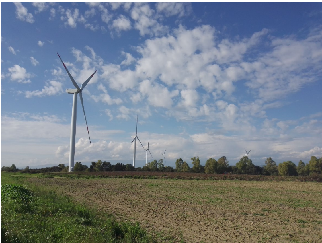
Figura 8 Vista dal punto 5
