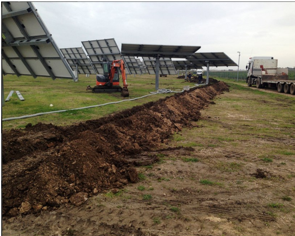
Figura 48: Esempio della fase di scavo trincee
