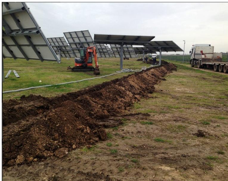
Figura 48: Esempio della fase di scavo trincee
