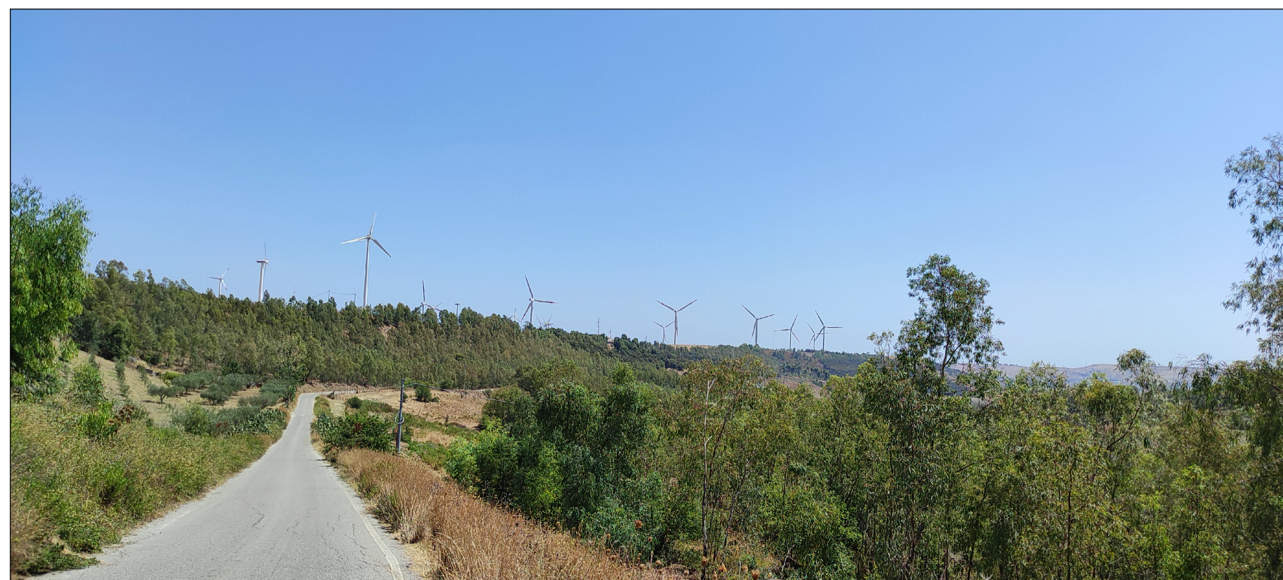
Vista dal sito di impianto
