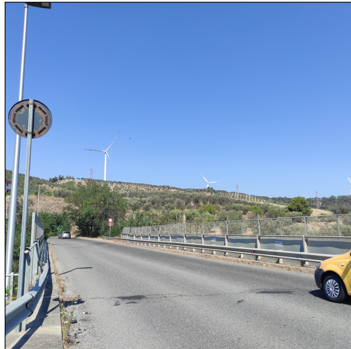
Vista da PV3a (SS106)
