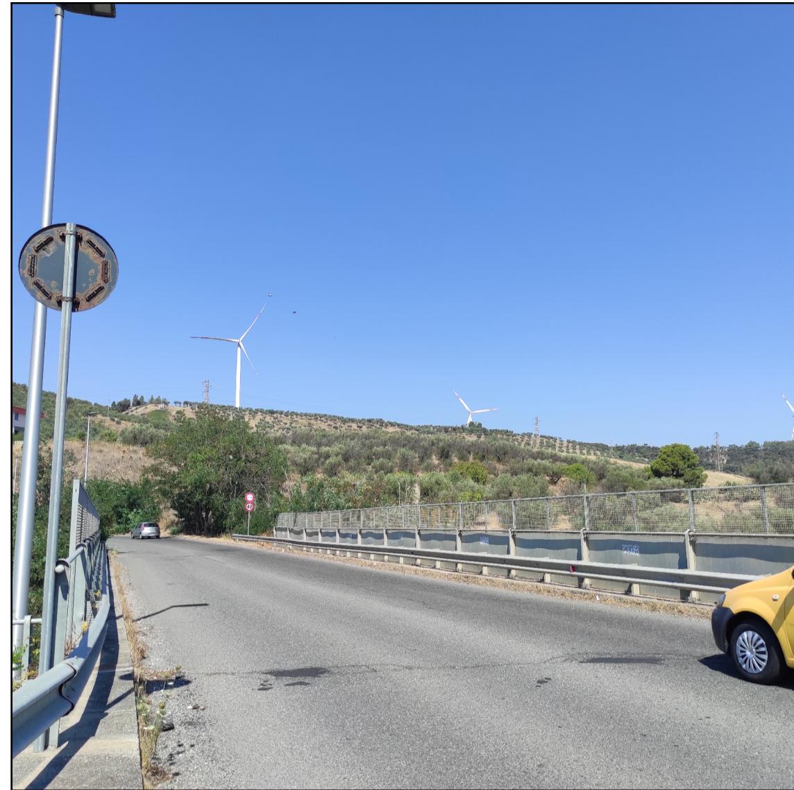
Vista da PV3a (SS106)
