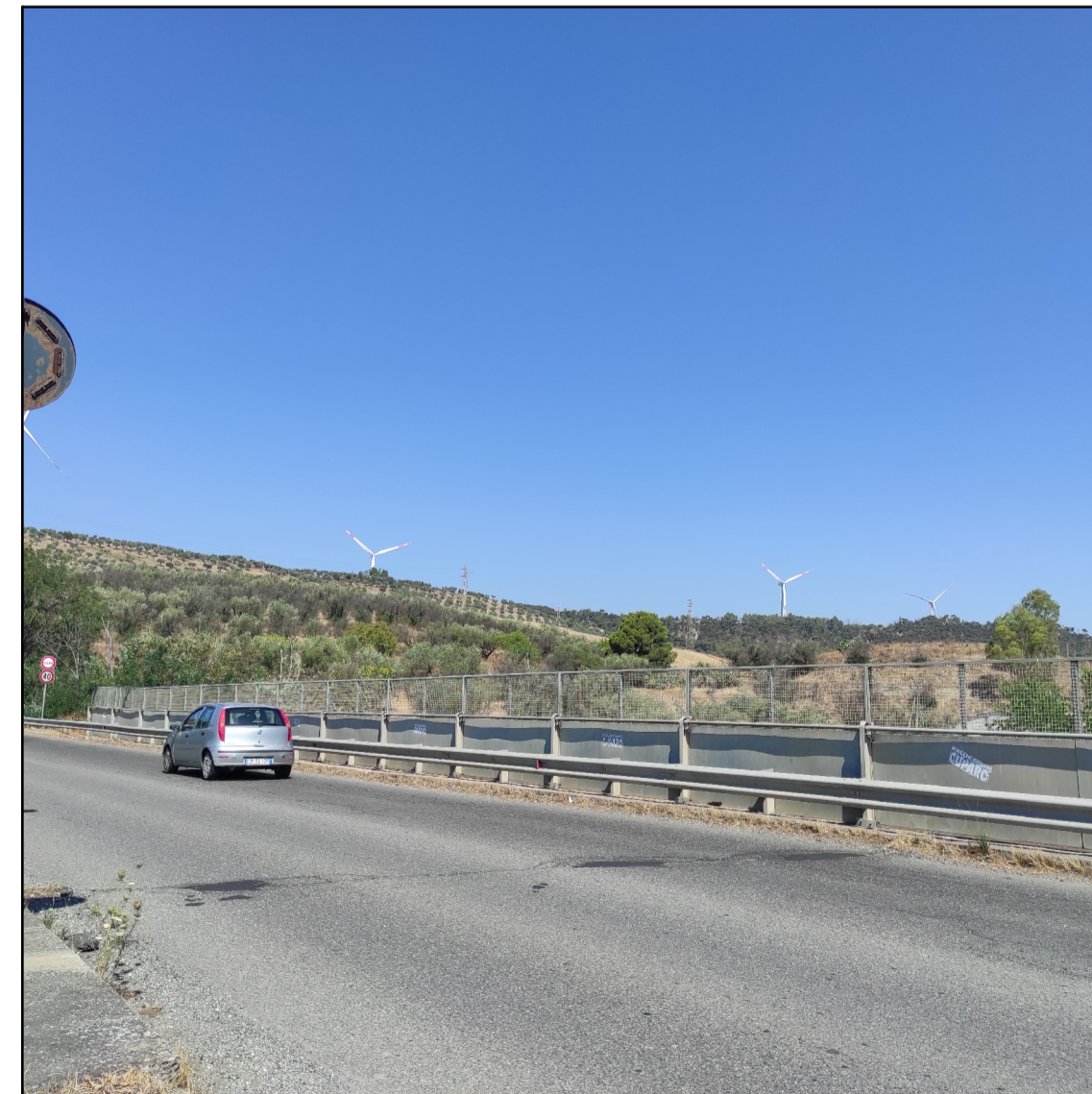
Vista da PV3b (SS106)
