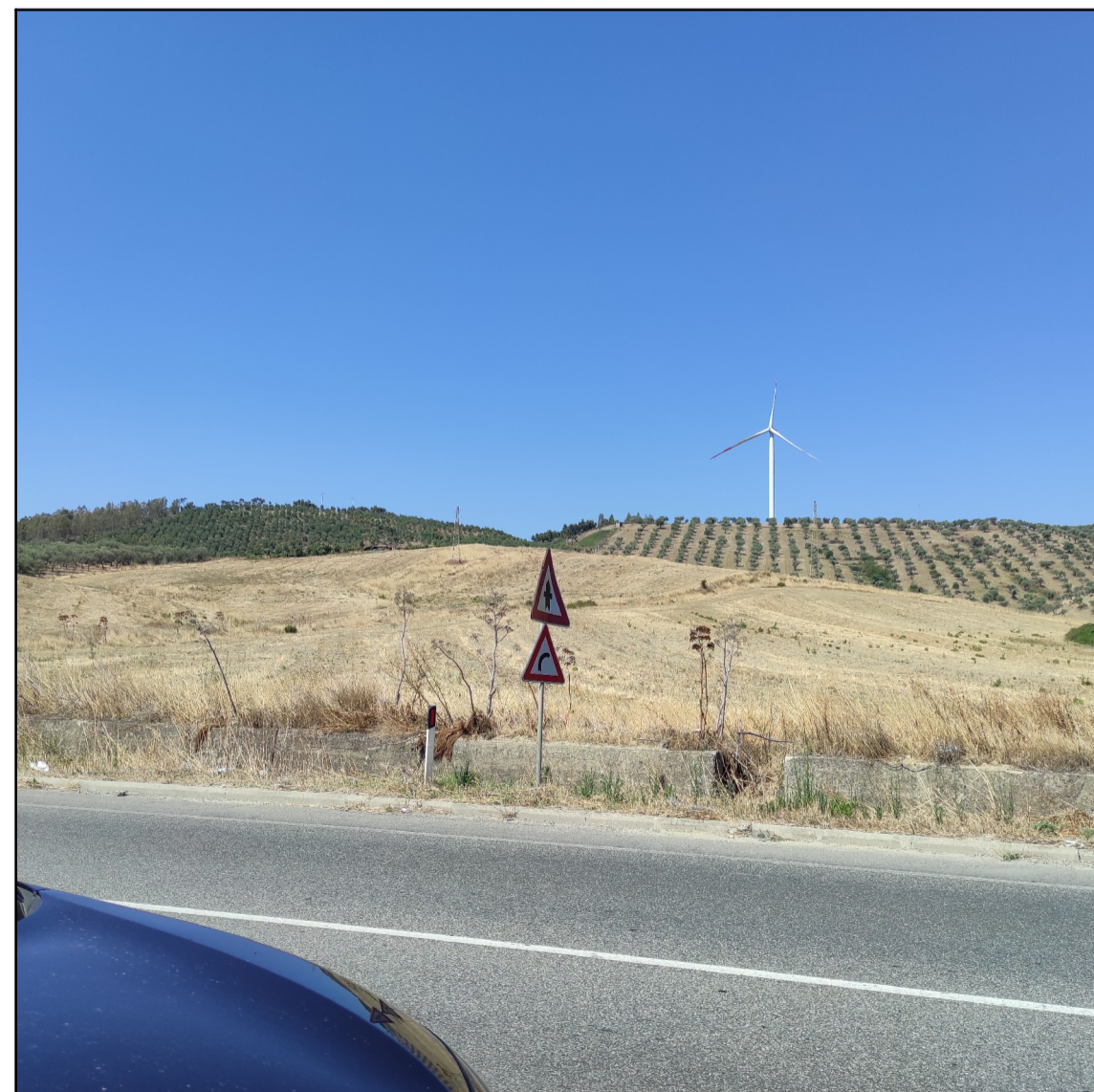
Vista da PV4a (SS106 e ferrovia)
