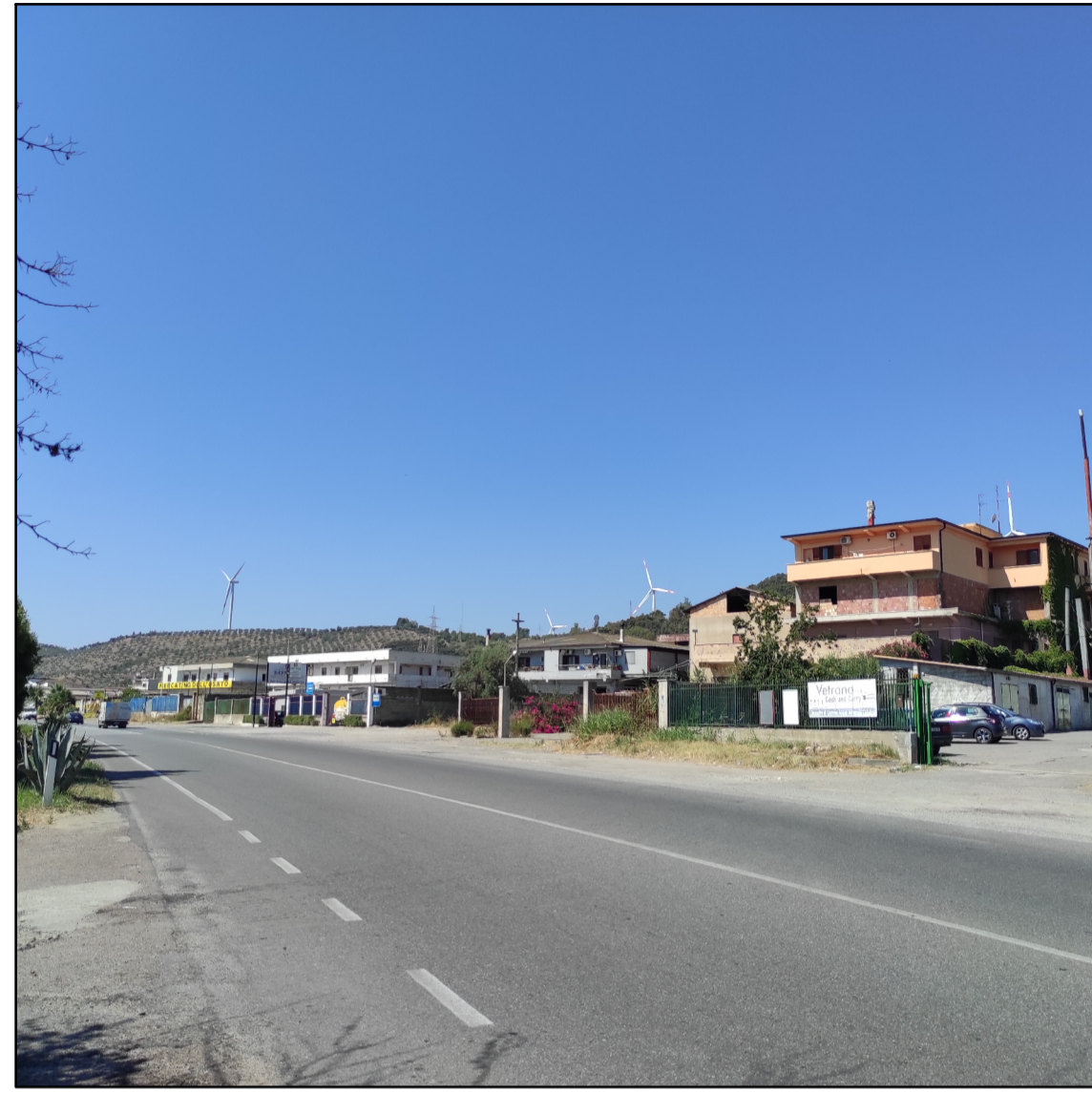
Vista da PV5a (SS106 e ferrovia)
