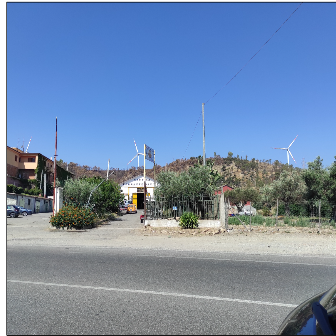
Vista da PV5b (SS106 e ferrovia)
