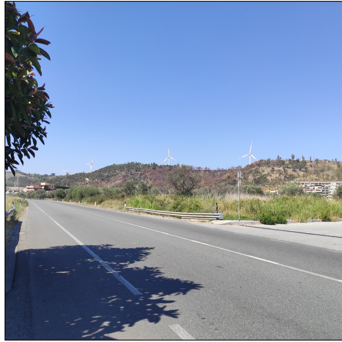
Vista da PV6 (SS106 e ferrovia)
