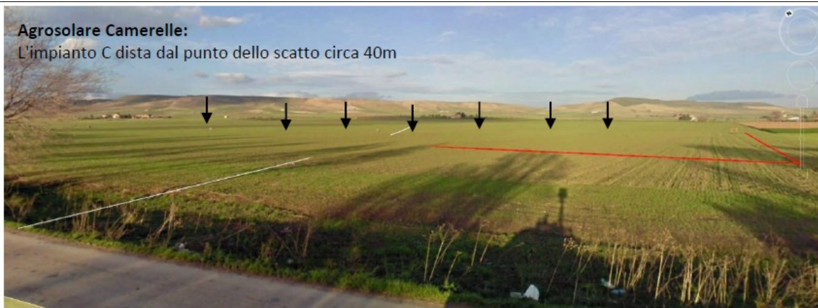
Figura 27 – foto dalla SP91 verso l'impianto C
