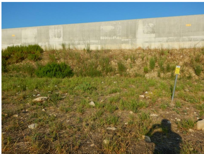
Figura 4 In direzione dell'area S1, da est. PV 1
