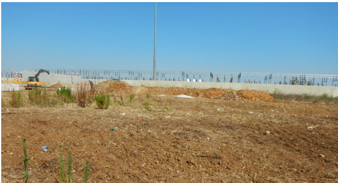
Figura 110 in direzione dell'area S35 da PV 34, da sud.
