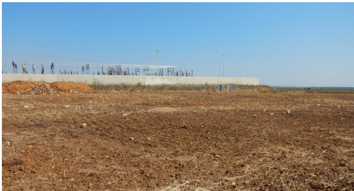
Figura 111 in direzione dell'area S35 da PV 34. Da sud.
