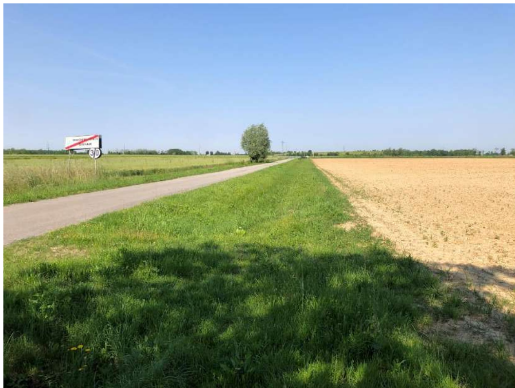
Foto 4 – Stato di Fatto
