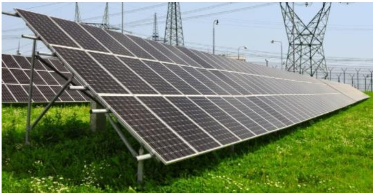
2 Inseguitore a rotolio: su pali infissi nel terreno e ruotano attorno all'asse est-ovest.
