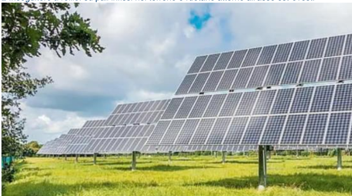
2 Inseguitore a rotolio: su pali infissi nel terreno e ruotano attorno all'asse est-ovest.
