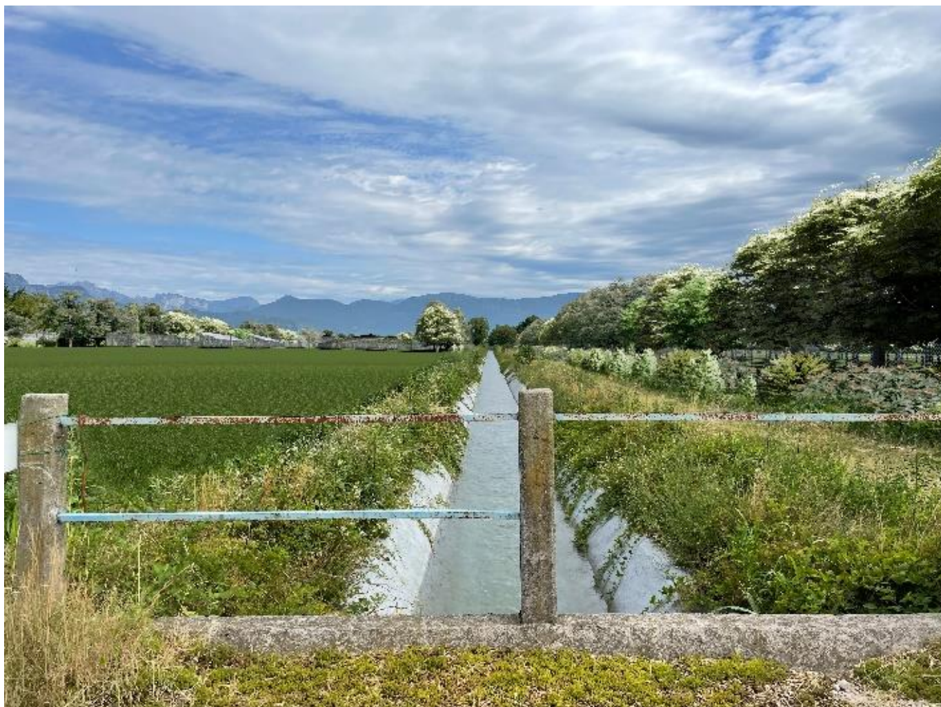
FIGURA 9 vista verso nord
