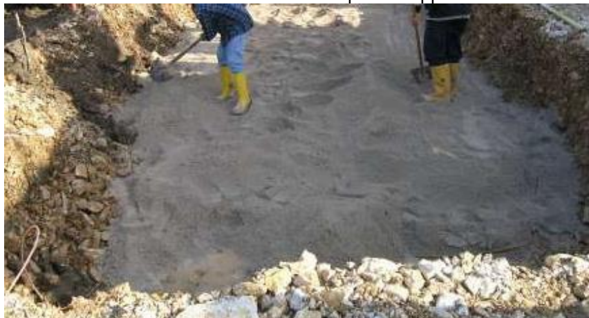
FIGURA 17 - SBANCAMENTO PIANO POSA CABINE
