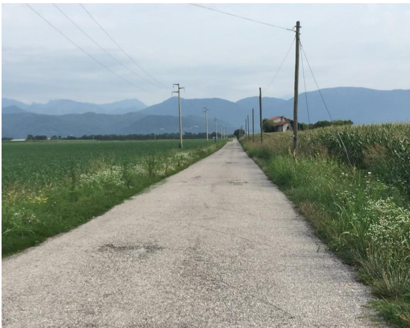
Figura 37 Strada Traviana (da Ovest)
