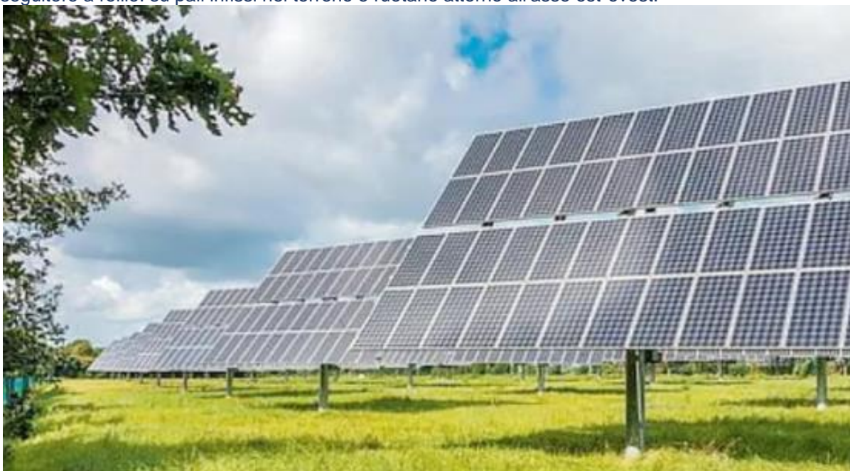
2 Inseguitore a rullo: su pali infissi nel terreno e ruotano attorno all'asse est-ovest.
