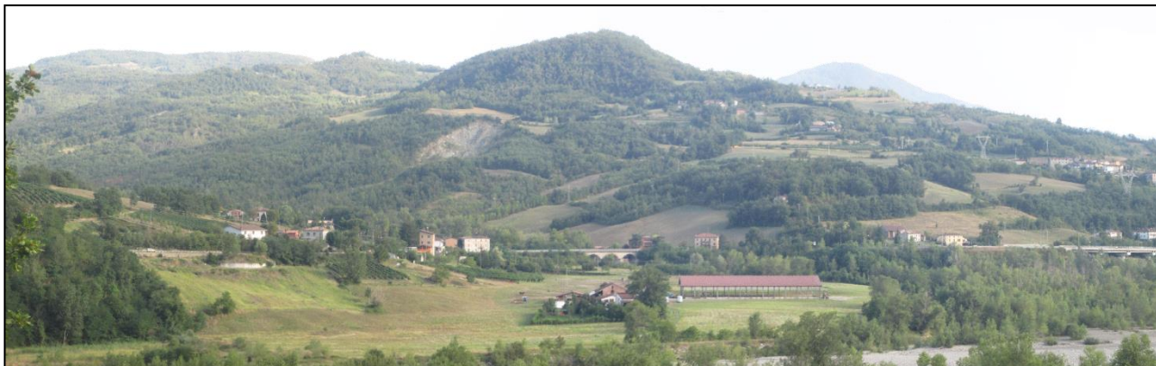
Viadotto Cernusca – Situazione attuale
