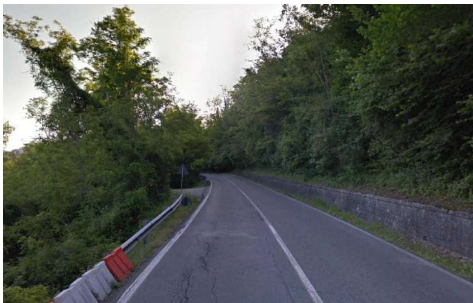
Figura 4-102: formazioni boscate di ripa di prevista eliminazione per l'adeguamento stradale in oggetto
