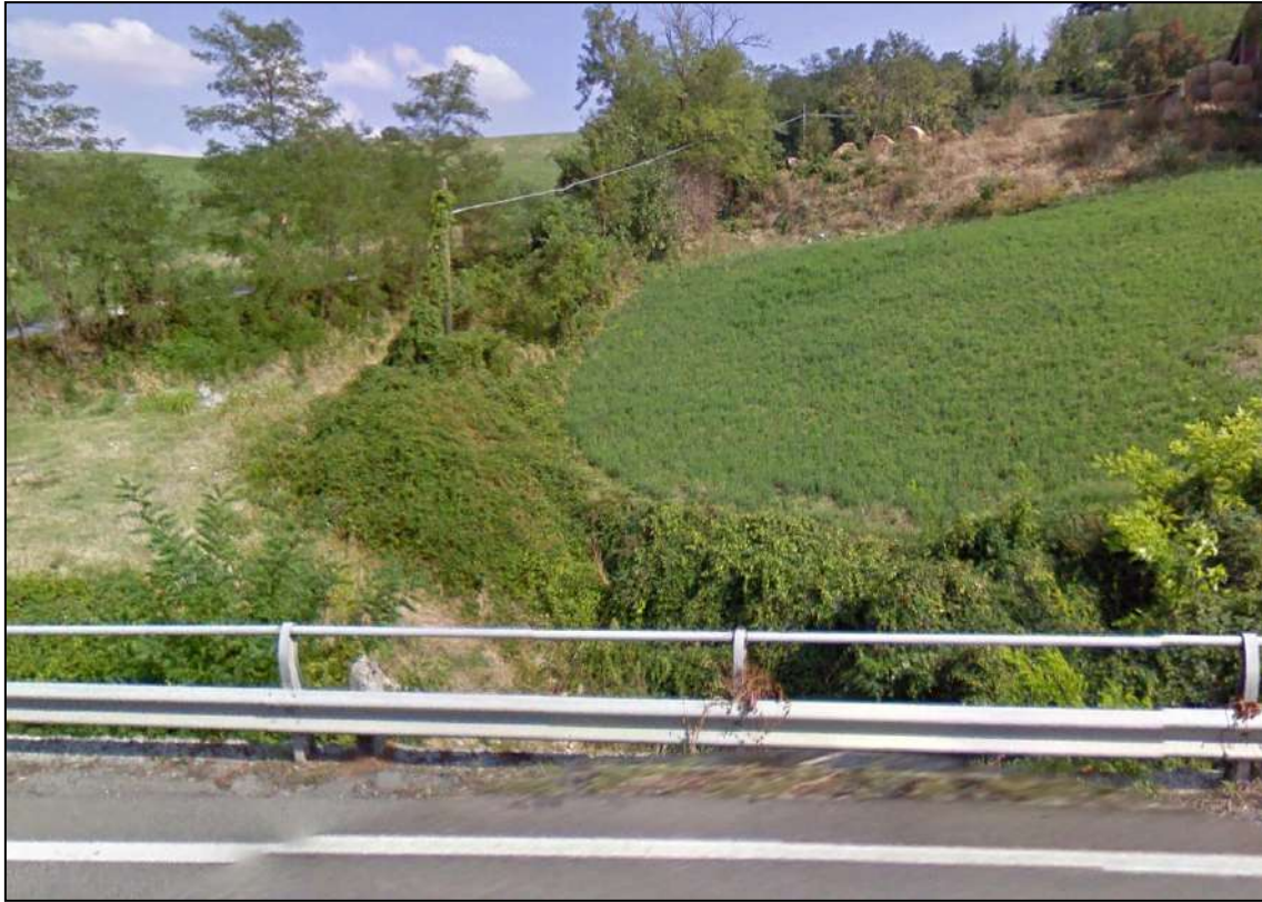
Figura 4.5.4.1 - Rio Savignano all'attraversamento della S.S. 45 (Comune di Rivergaro)
