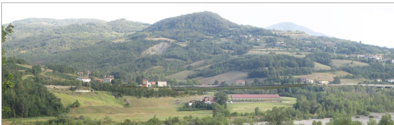
Viadotto Cernusca – Integrazione progettuale: struttura in acciaio verniciato RAL 6017 ed estensione delle opere di sistemazione a verde lungo il tratto in rilevato
