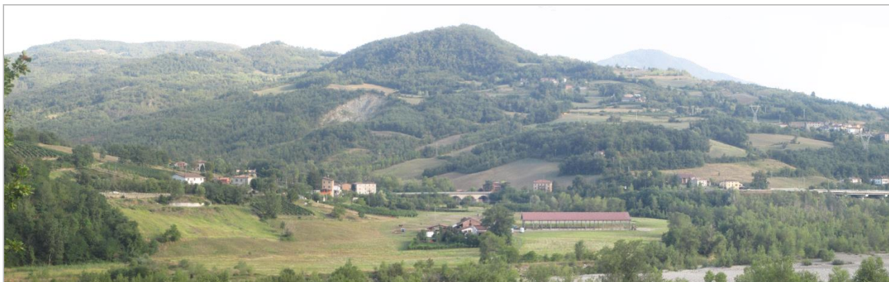
Viadotto Cernusca – Situazione attuale
